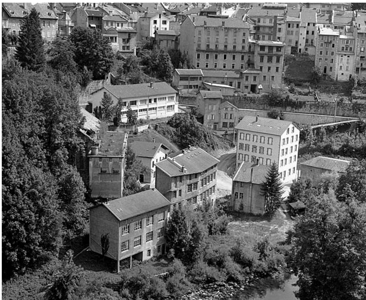
Vue d'ensemble rapprochée depuis le nord-ouest.
