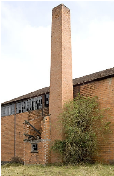
Cheminée et atelier de fabrication.
