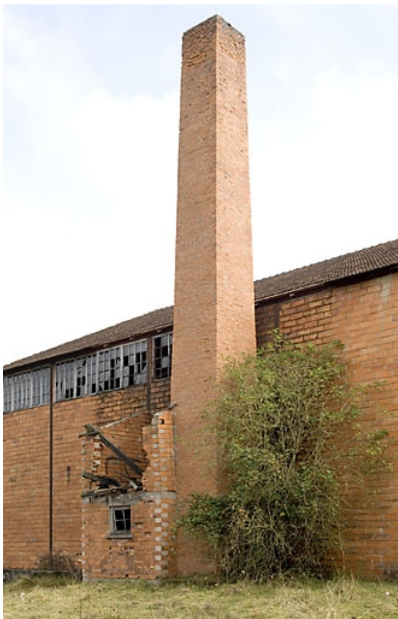
Cheminée et atelier de fabrication.
