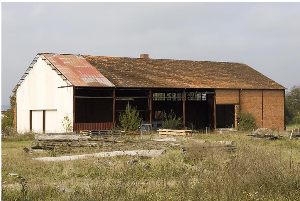
Atelier de fabrication depuis le sud-est.
