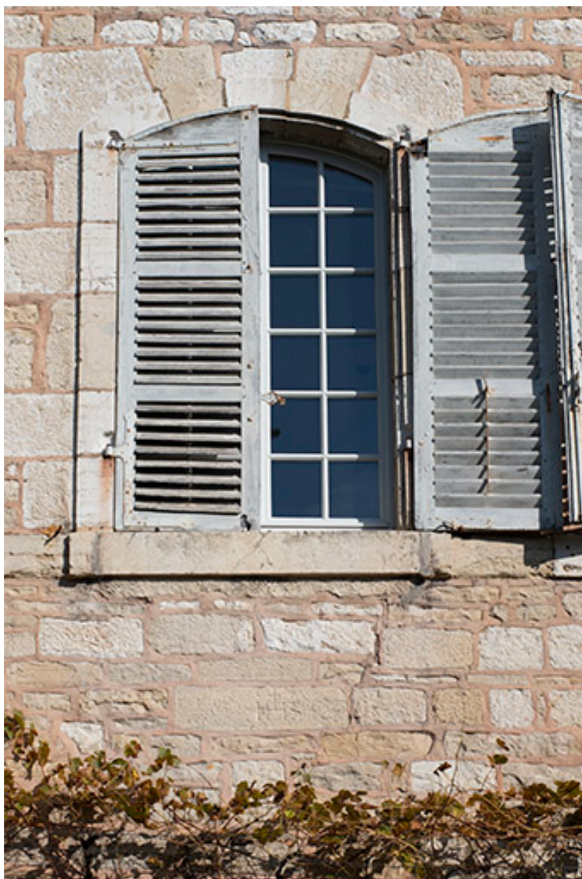
Fenêtre du rez-de-chaussée (façade ouest).
