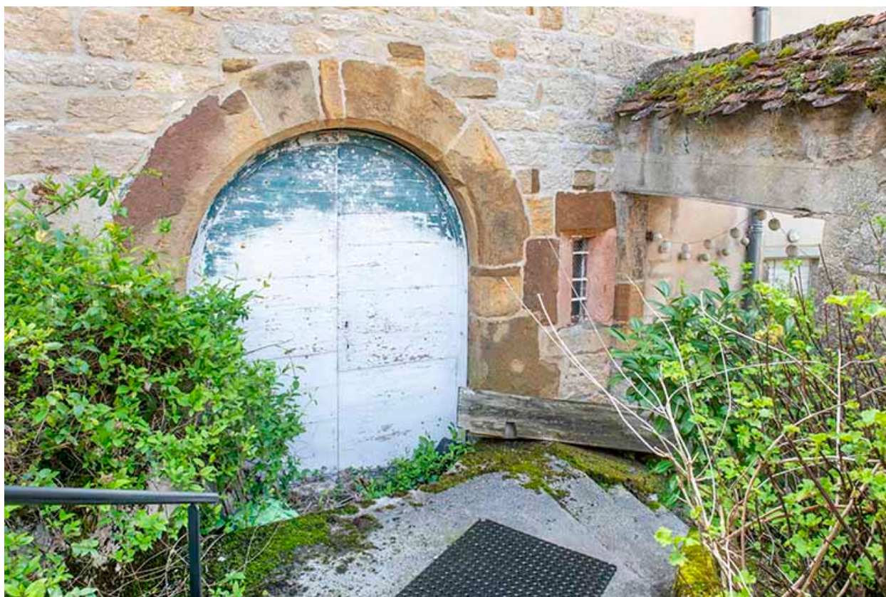
Porte de cave (façade nord).
