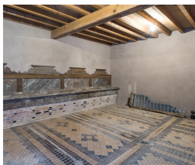
Corps central : écurie. Phot. Pierre-Marie Barbe-Richaud IVR26_20212100531NUC2A
