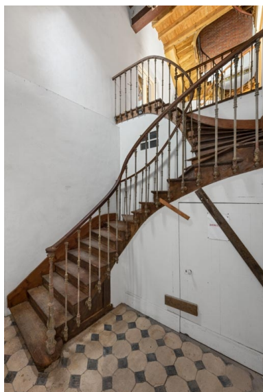
Corps sud : escalier desservant le 1er étage. Phot. Pierre-Marie Barbe-Richaud IVR26_20212100493NUC4A
