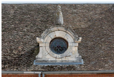
Elévation antérieure : oeil- de-boeuf du corps central. Phot. Pierre-Marie Barbe-Richaud IVR26_20222100912NUC4A
