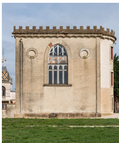
Elévation latérale droite (corps sud). Phot. Pierre-Marie Barbe-Richaud IVR26_20222100894NUC2A
