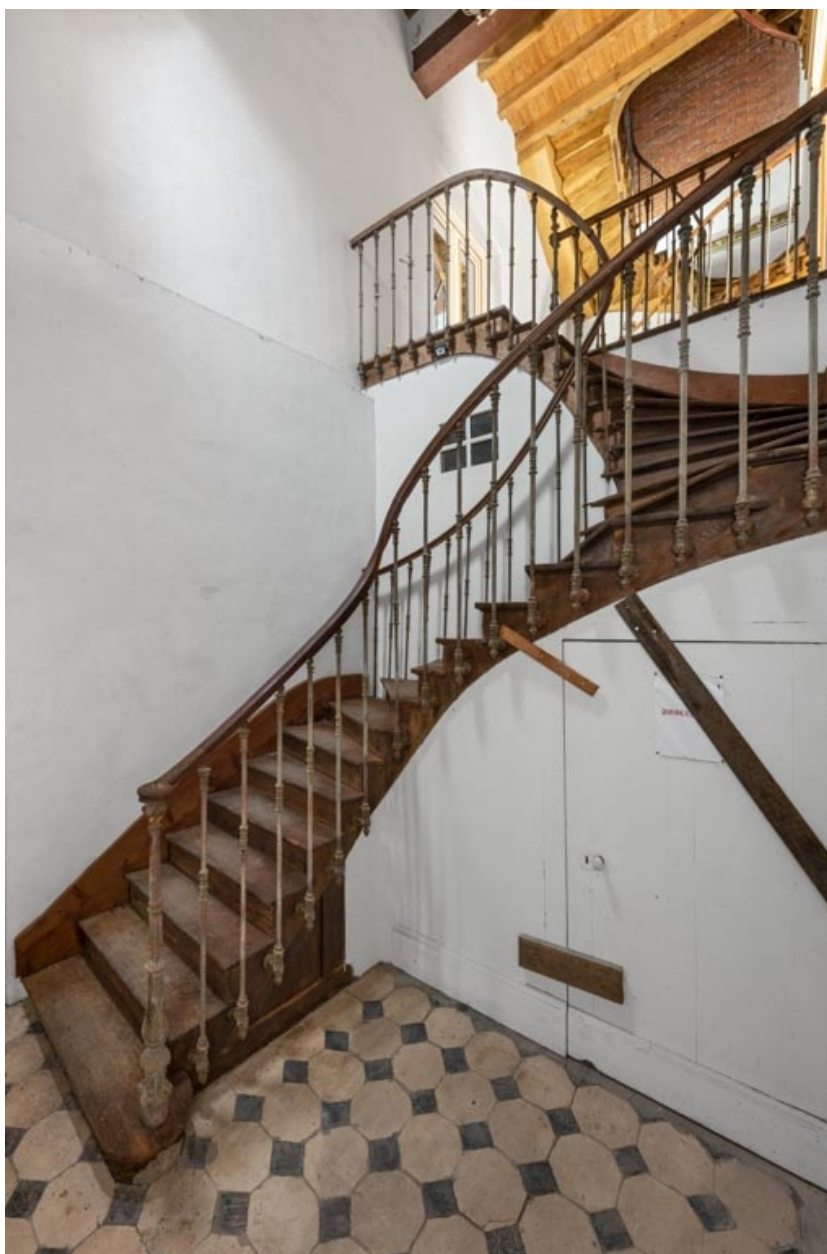
Corps sud : escalier desservant le 1er étage.
