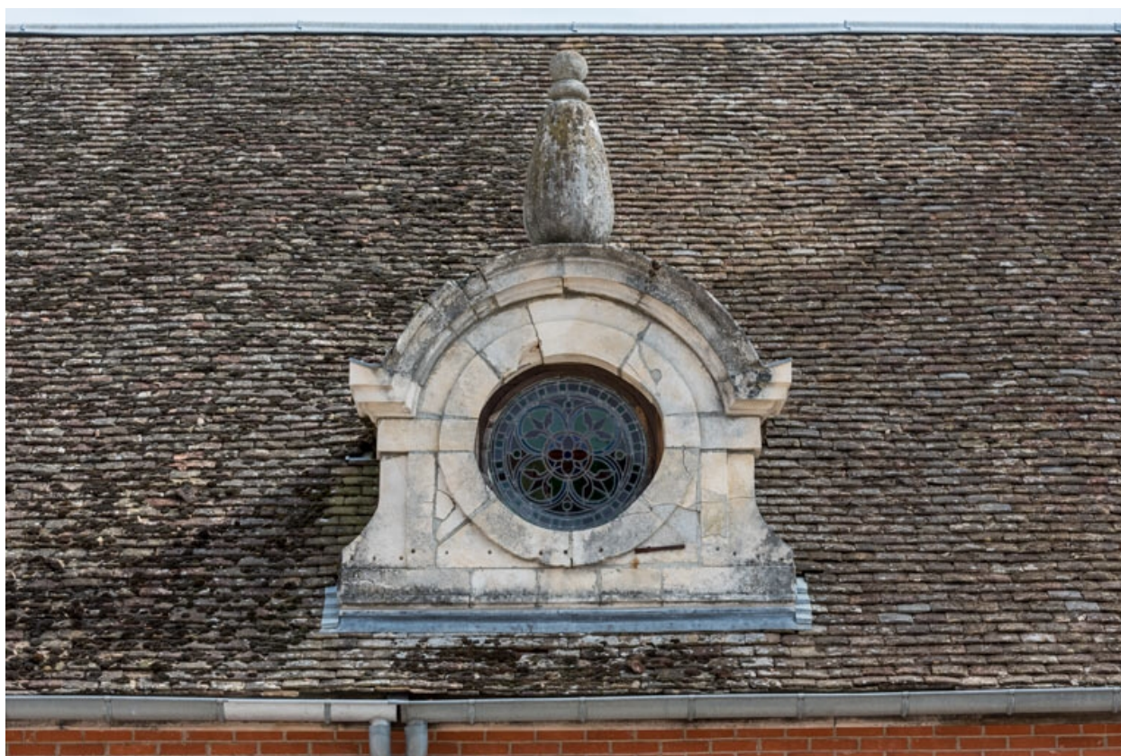
Elévation antérieure : oeil-de-boeuf du corps central.
