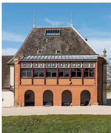
Elévation postérieure : le foyer, adossé au corps nord. Noter la tabatière dans le toit, donnant de la lumière à la salle. Phot. Pierre-Marie Barbe-Richaud IVR26_20222100118NUC2A
