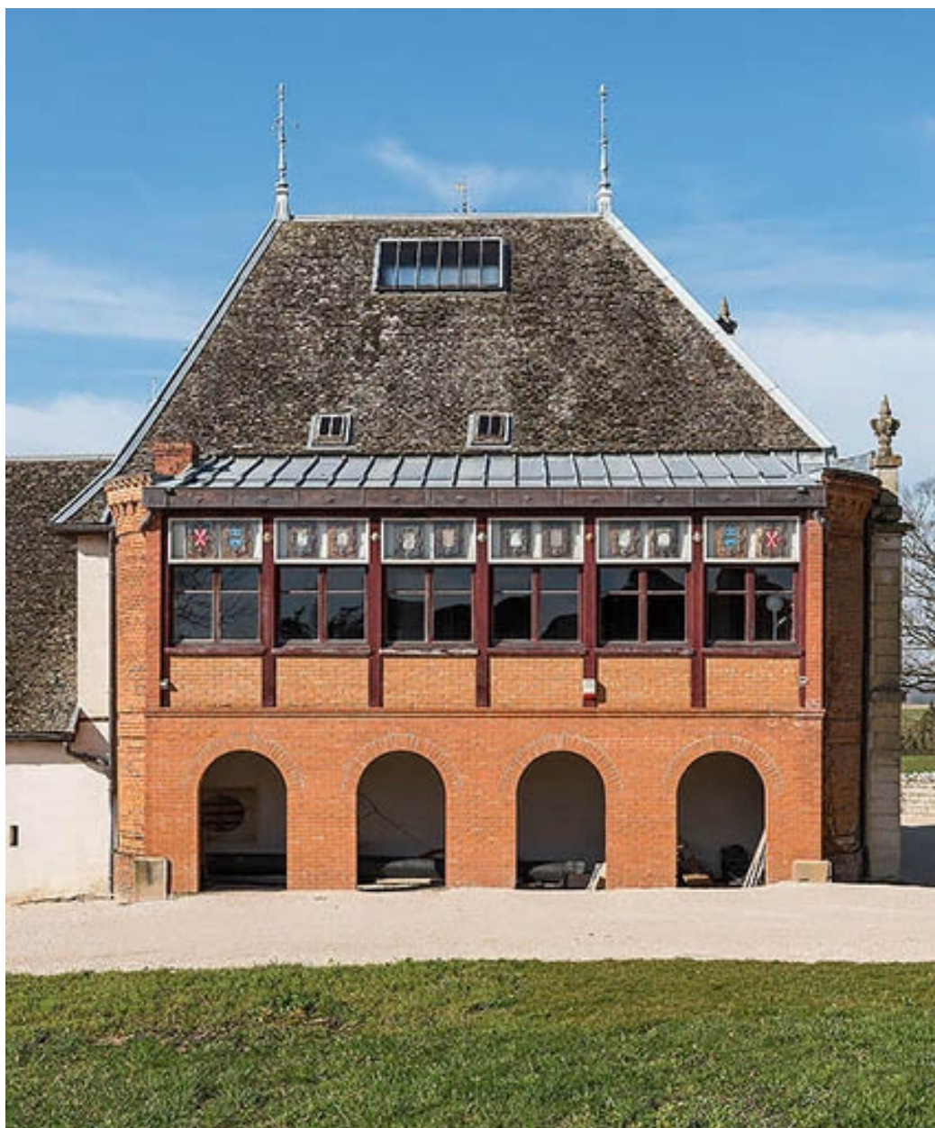
Elévation postérieure : le foyer, adossé au corps nord. Noter la tabatière dans le toit, donnant de la lumière à la salle.
