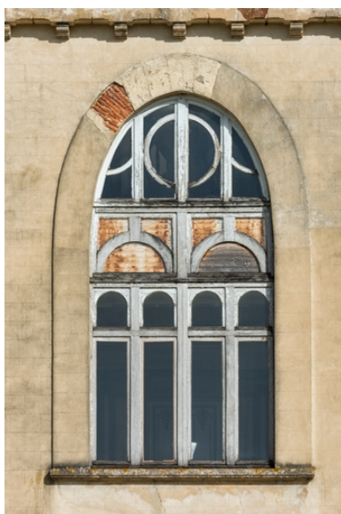
Elévation latérale droite (corps sud) : fenêtre. Phot. Pierre-Marie Barbe-Richaud IVR26_20222100895NUC4A
