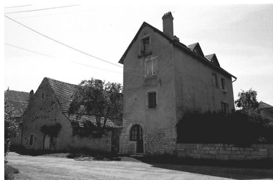
Vue d'ensemble. Phot. Bernard Lardière IVR43_19817000510Z
