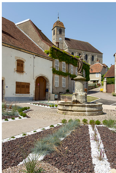
Vue générale. Phot. Sonia Dourlot IVR43_20167000699NUC4A
