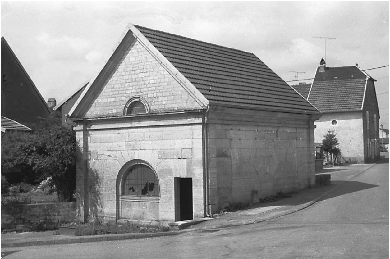
Vue d'ensemble depuis la place de l'église.
