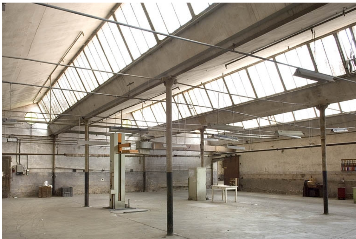
Atelier désaffecté de la filature.
