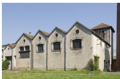
Pignons de la chaufferie. Phot. Jérôme Mongreville IVR43_20097000728NUC2A
