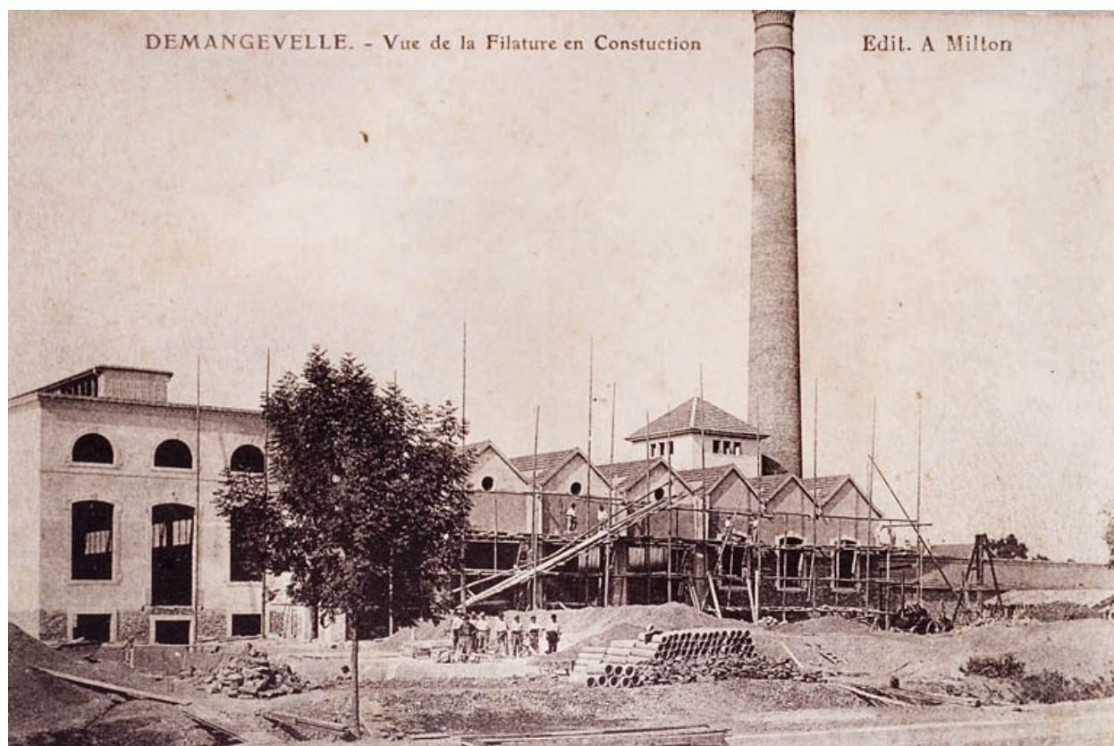
Demangevelle. - Vue de la filature en construction.
