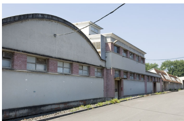
Façade nord de l'atelier de filature. Phot. Jérôme Mongreville IVR43_20097000730NUC2A
