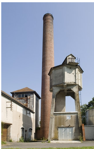
Cheminée et château d'eau. Phot. Jérôme Mongreville IVR43_20097000726NUC2A
