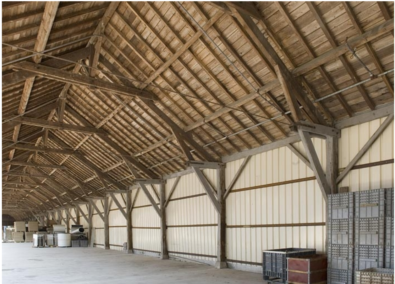
Fermes de la charpente de l'entrepôt industriel.
