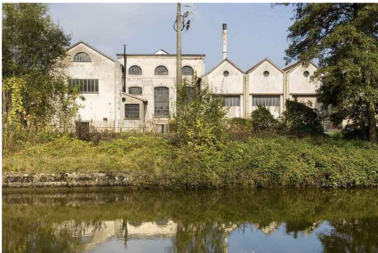
Bâtiments techniques depuis le sud.
