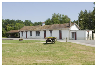
Entrepôt industriel vu de trois quarts. Phot. Jérôme Mongreville IVR43_20097000742NUC2A
