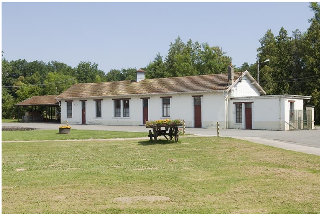
Entrepôt industriel vu de trois quarts.
