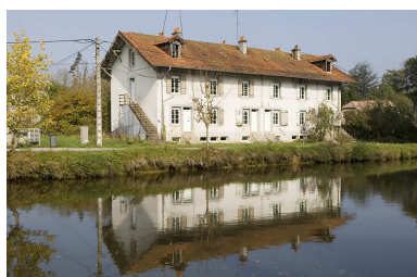
Maison I de la cité ouvrière. Phot. Jérôme Mongreville IVR43_20077000553NUCA
