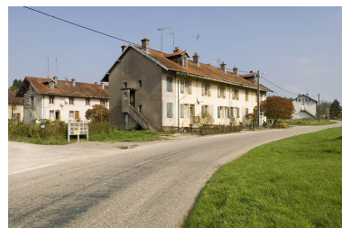
Cité ouvrière, depuis l'ouest. Phot. Jérôme Mongreville IVR43_20077000558NUCA
