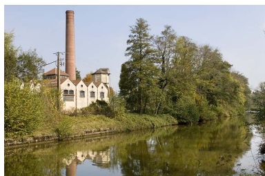
Vue d'ensemble depuis le sud du canal. Phot. Jérôme Mongreville IVR43_20077000562NUCA
