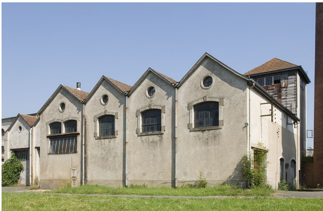
Pignons de la chaufferie.
