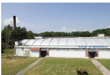
Vue plongeante sur l'atelier de filature. Phot. Jérôme Mongreville IVR43_20097000745NUC2A
