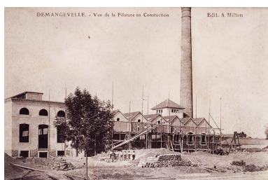
Demangevelle. - Vue de la filature en construction. Phot. Jérôme Mongreville IVR43_20077000684NUCA
