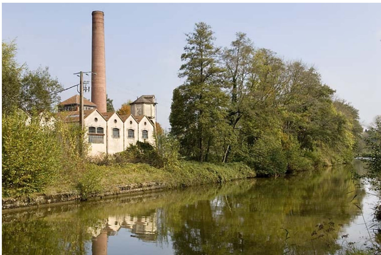
Vue d'ensemble depuis le sud du canal.
