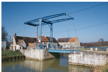
Pont mobile dit pont-levis à flèches de Pousseaux. Phot. Jean-Luc Duthu IVR26_20015800044ZA
