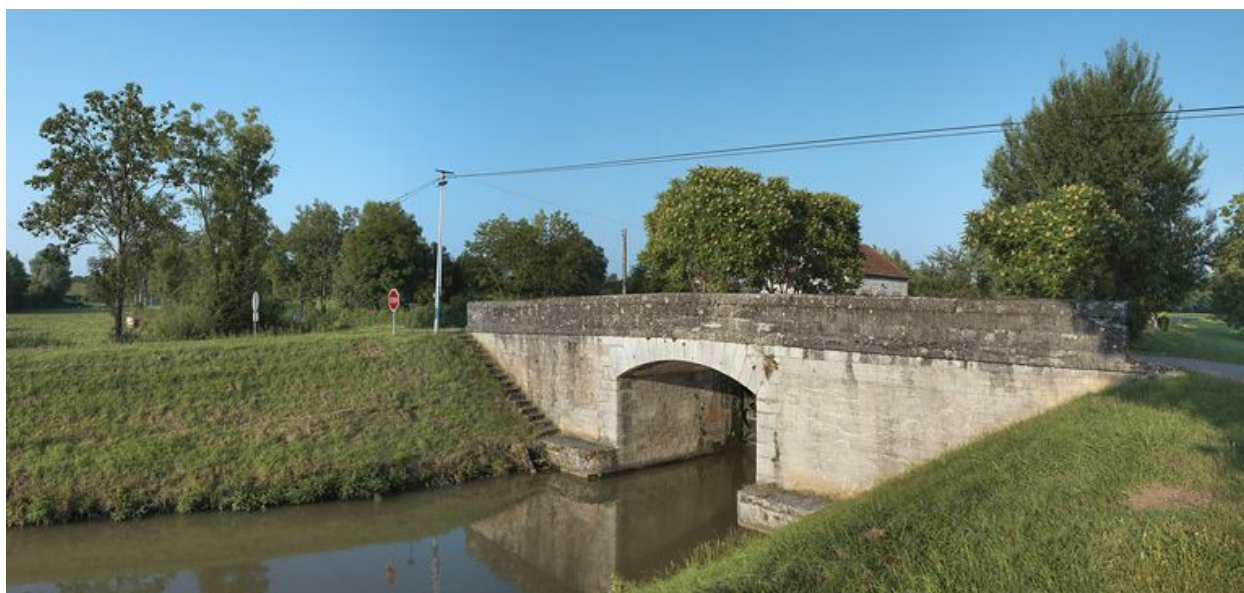
Vue d'aval du pont sur l'écluse 22 du versant Loire, dite de Bernay.
