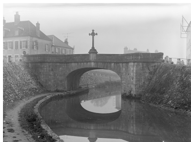
Pont routier isolé de Châtillon-en-Bazois. Phot. non renseigné IVR26_19755800874V
