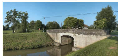
Vue d'aval du pont sur l'écluse 22 du versant Loire, dite de Bernay. Phot. Thierry Kuntz IVR26_20135800247NUC4A
