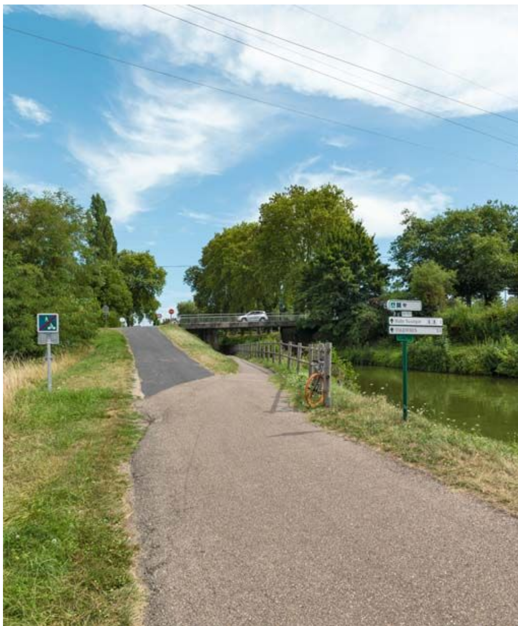
Vue d'ensemble du pont.
