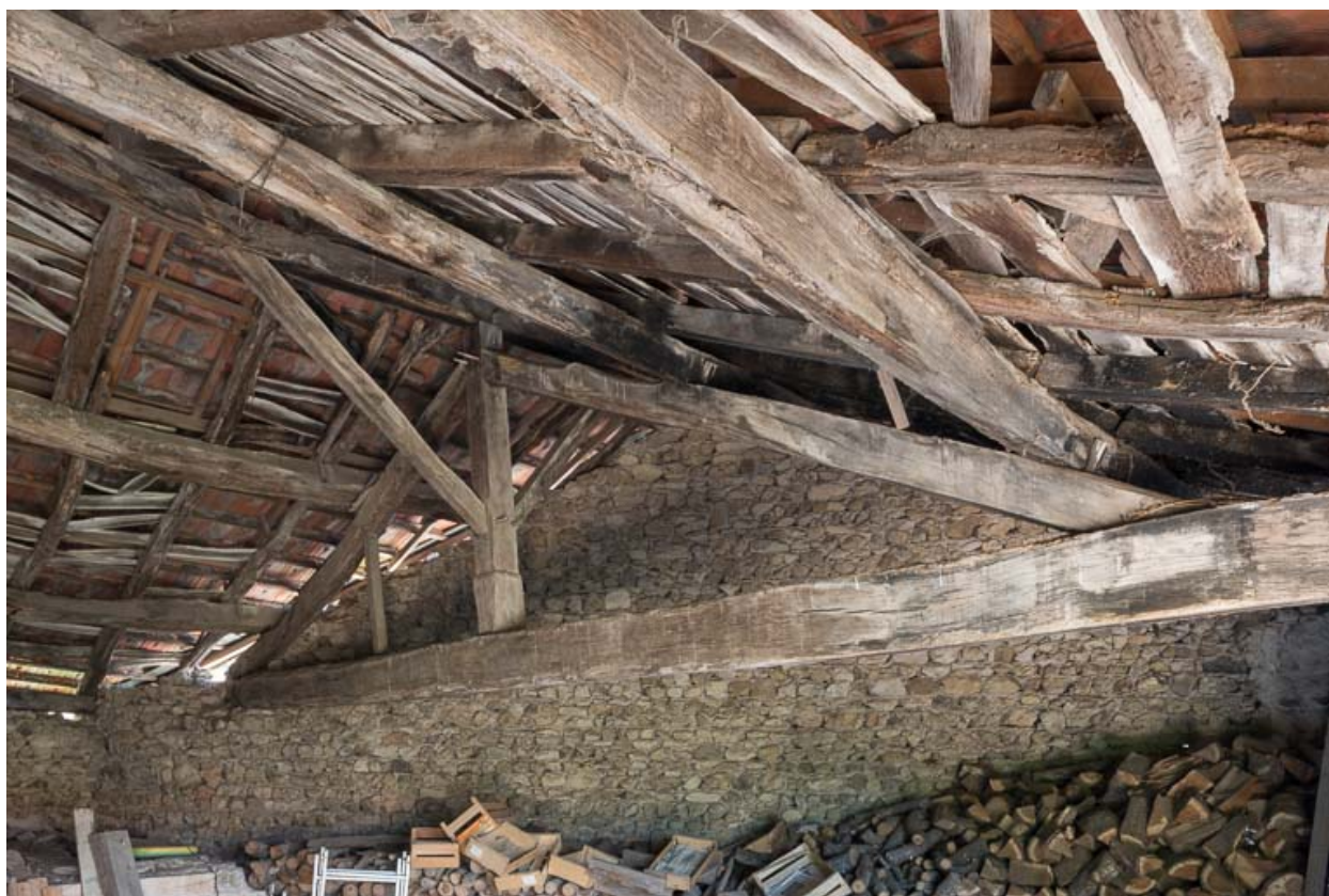
Charpente du cuvage
