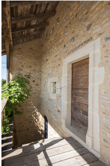
Vue de la galerie, protégée par un débord de toit soutenu par le dépassement des murs-pignons Phot. Pierre-Marie Barbe-Richaud IVR26_20197100248NUC4A
