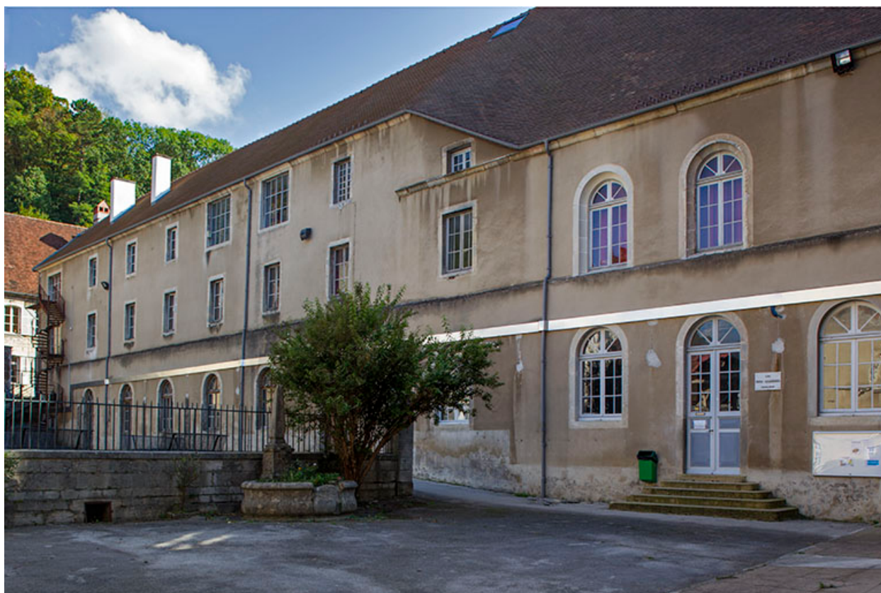
Site des oratoriens : façades sur cour.
