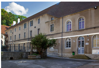
Site des oratoriens : façades sur cour. Phot. Sonia Dourlot IVR43_20143900731NUC2A
