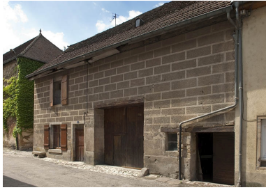
Façade antérieure, vue de trois quart droit.
