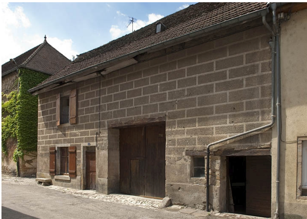
Façade antérieure, vue de trois quart droit.
