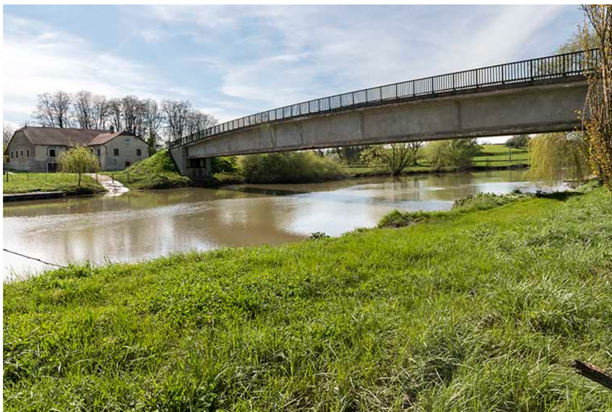
Franchissement de la Saône : pont de Fouchécourt.
