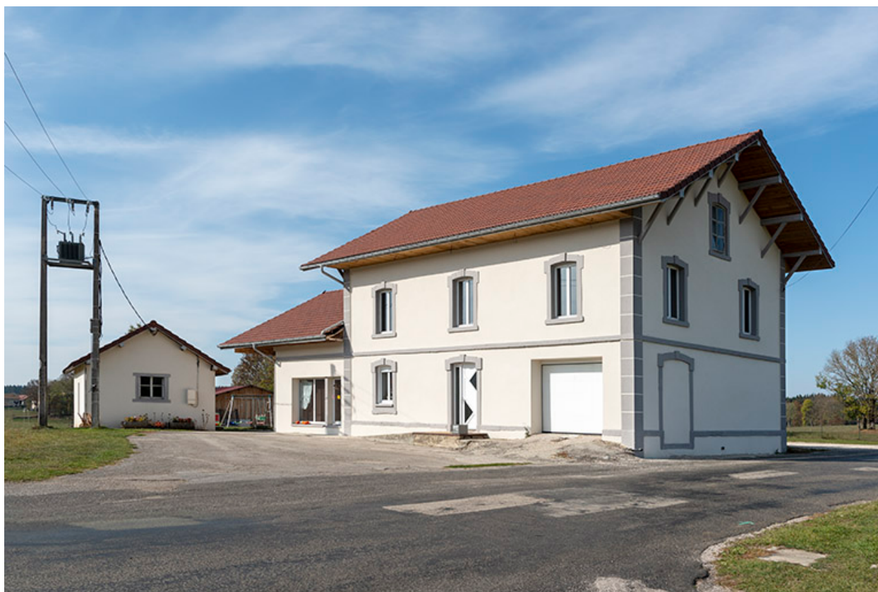
Fromagerie : façades antérieure et latérale droite.
