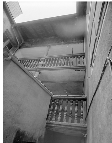
Galleries de liaison. Phot. Jérôme Mongreville IVR43_19882500224V
