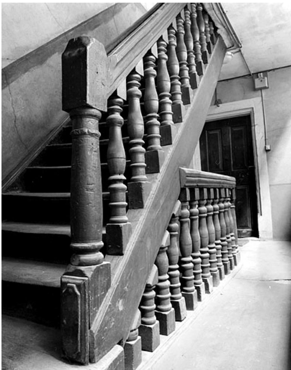
Escalier vu au niveau du premier étage.
