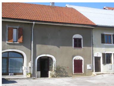
Vue de la façade antérieure. Phot. Marie-Pierre Reynet IVR43_20083900093NUC1A
