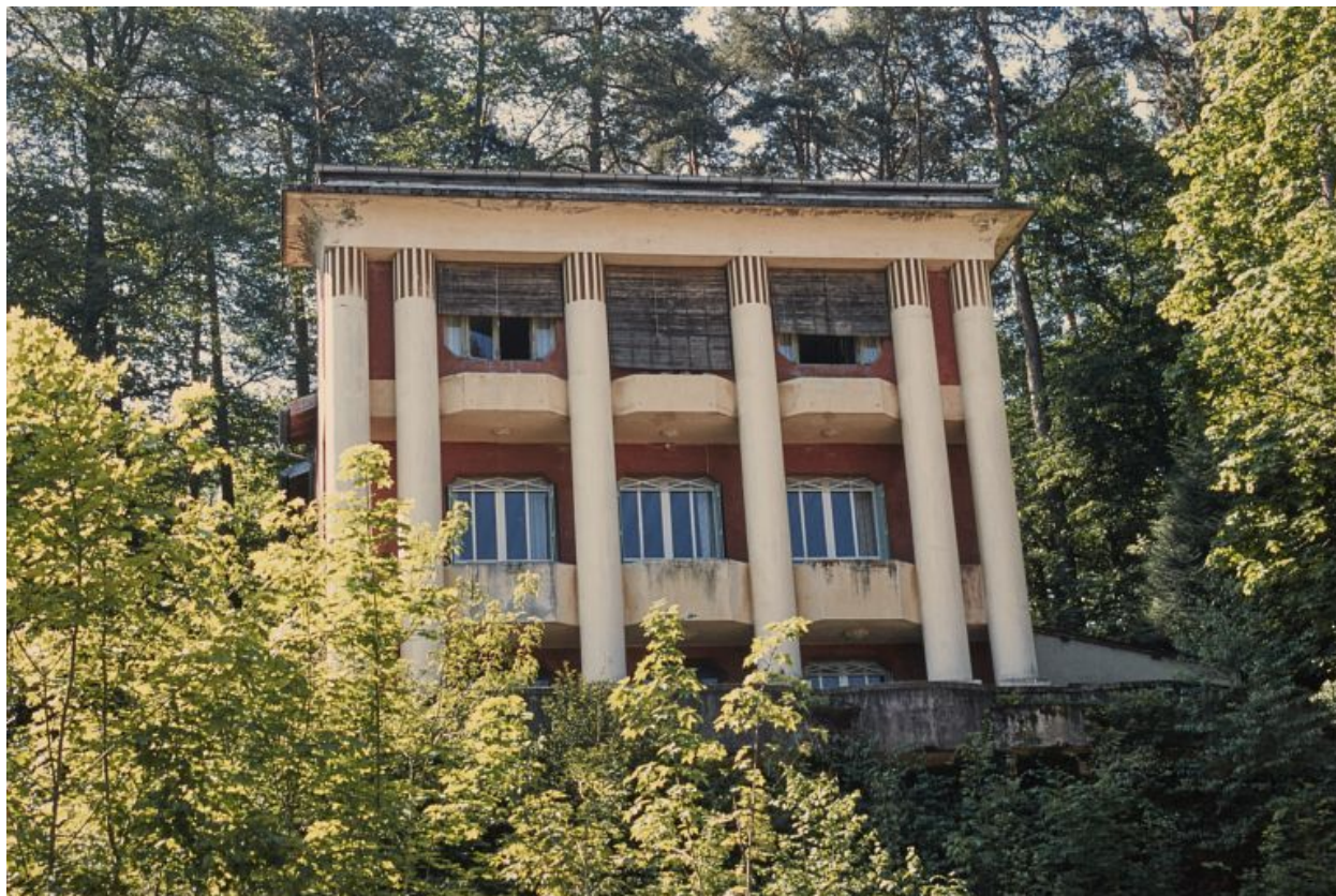
Façade nord, vue de face.
