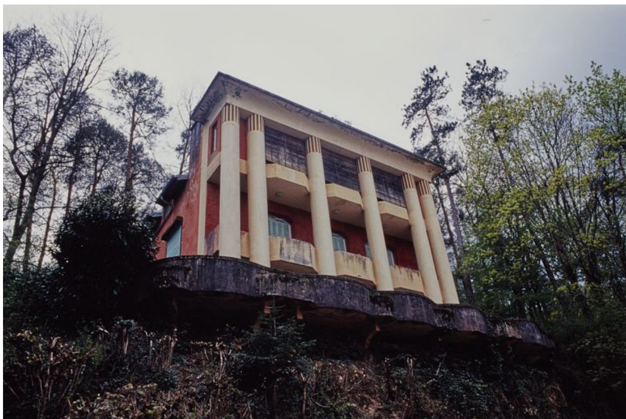
Façade nord, vue en contre-plongée.
