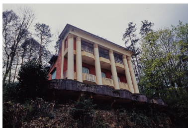
Façade nord, vue en contre-plongée. Phot. Jean-Luc Duthu IVR26_20025800173ZA
