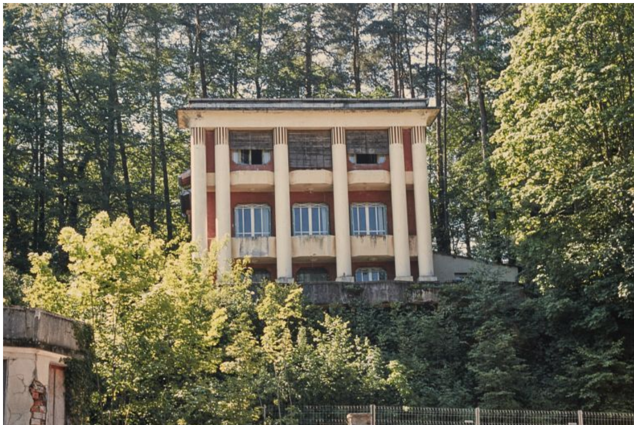
Façade nord, vue de face.
