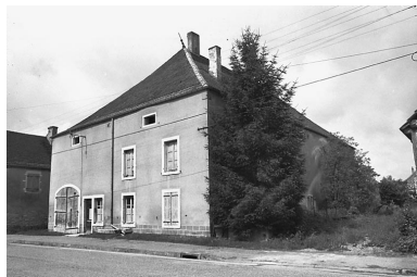
Façade antérieure sur rue. Phot. Bernard Lardière IVR43_19817000267Z
