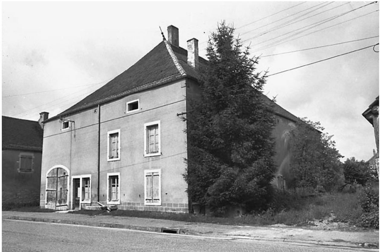
Façade antérieure sur rue.
