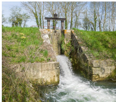
Le déversoir en contrebas du canal. Phot. Pierre-Marie Barbe-Richaud IVR26_20138900036NUC4AQ
