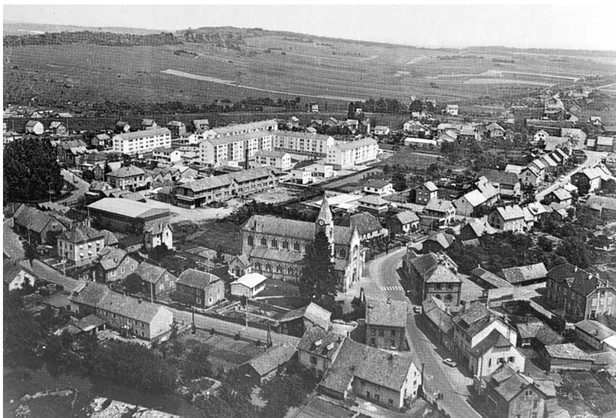
Danjoutin (Territoire de Belfort). Vue générale.
