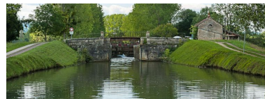
Vue du pont depuis l'aval. Phot. Pierre-Marie Barbe-Richaud IVR26_20112103988NUC4AQ
