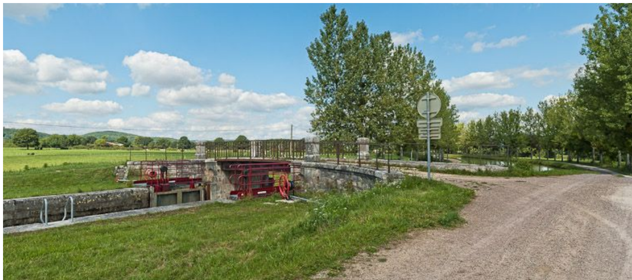
Vue du pont depuis l'amont.
