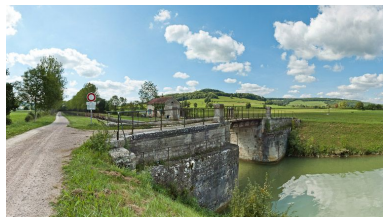
Vue du pont. Phot. Pierre-Marie Barbe-Richaud IVR26_20112103989NUC4AQ
