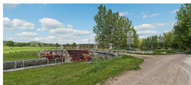
Vue du pont depuis l'amont. Phot. Pierre-Marie Barbe-Richaud IVR26_20112103990NUC4AQ
