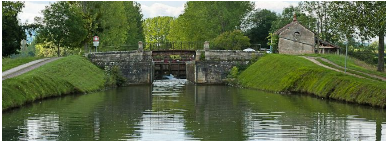
Vue du pont depuis l'aval.
