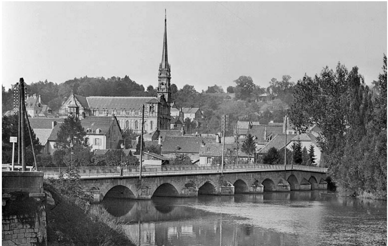
Pont Armand Bermont situé rue Charles Lalance.
