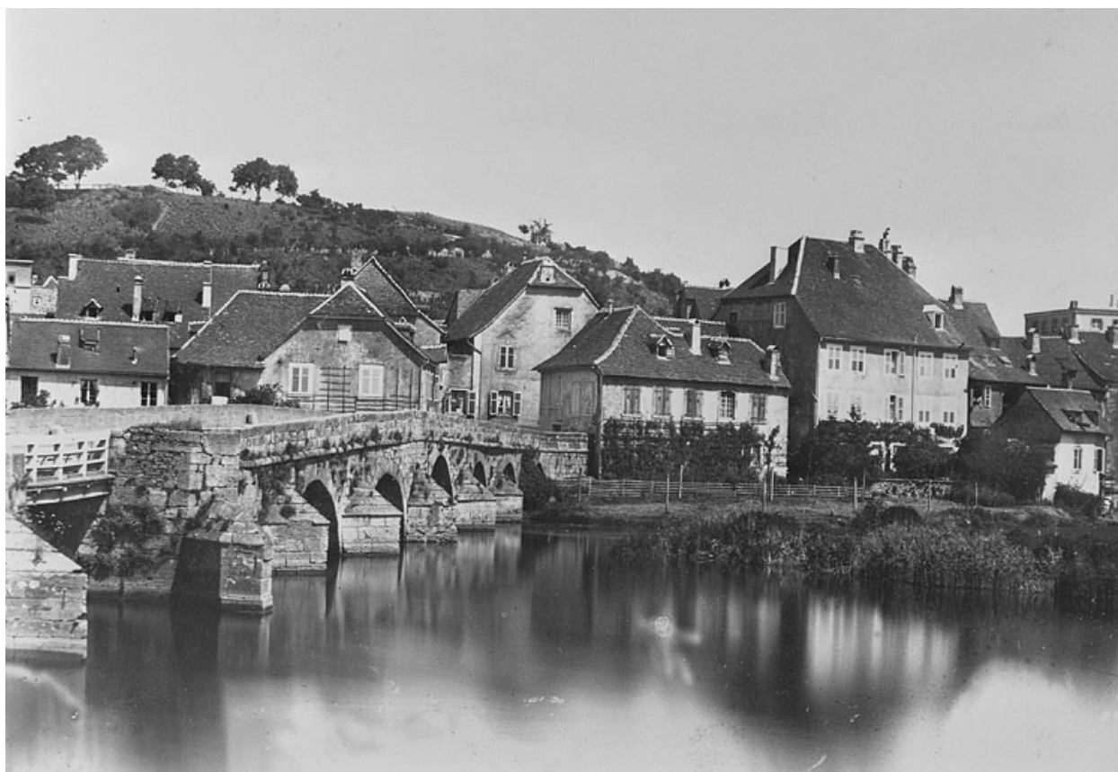
Pont Armand Bermont situé rue Charles Lalance.
