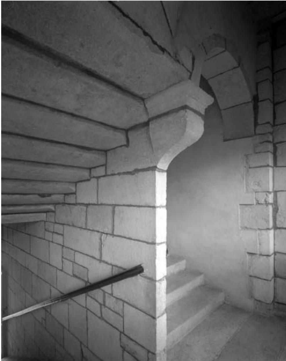
Détail de la montée d'escalier.
