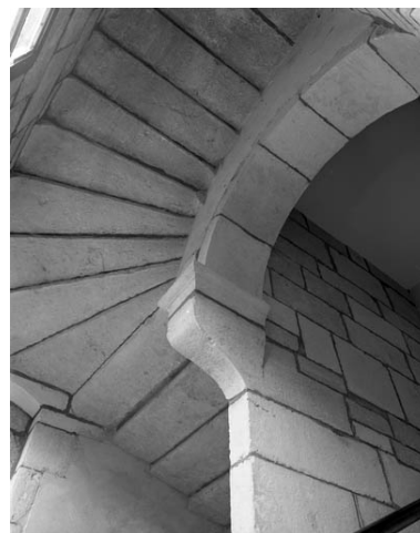
Détail d'une volée d'escalier. Phot. Yves Sancey IVR43_19917000003X
