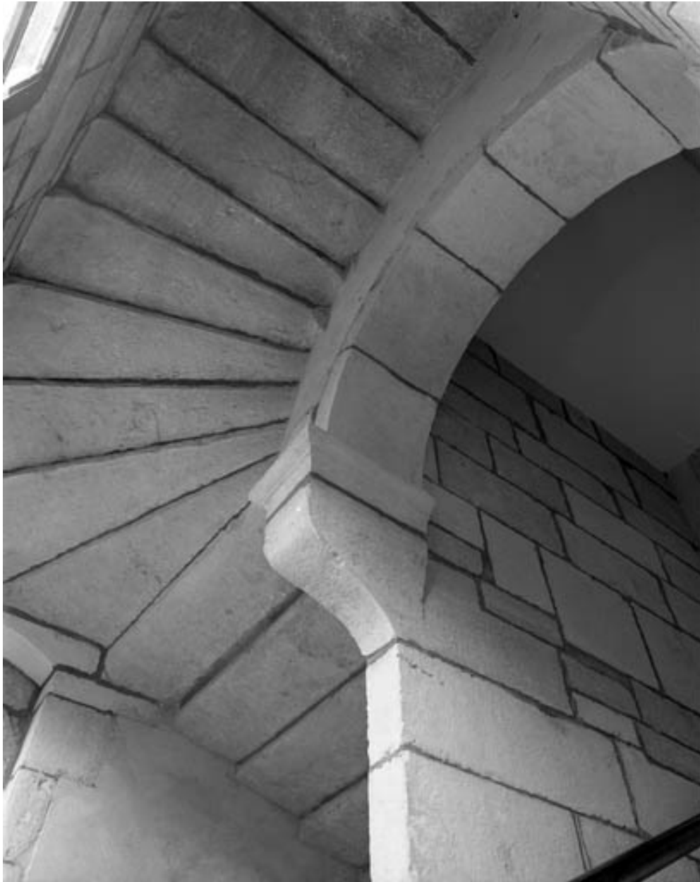
Détail d'une volée d'escalier.
