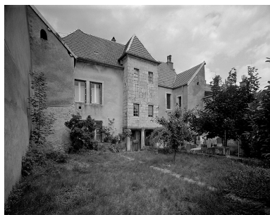
Façade postérieure. Phot. Yves Sancey IVR43_19917000001V
