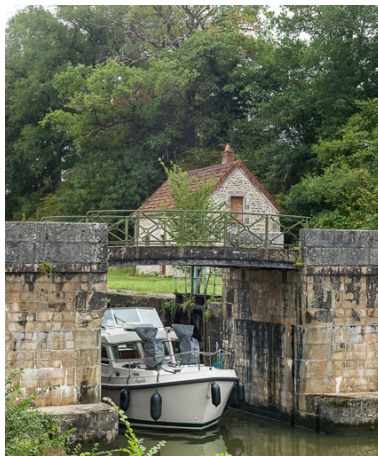
Vue du pont. Phot. Pierre-Marie Barbe-Richaud IVR26_20175800321NUC2A
