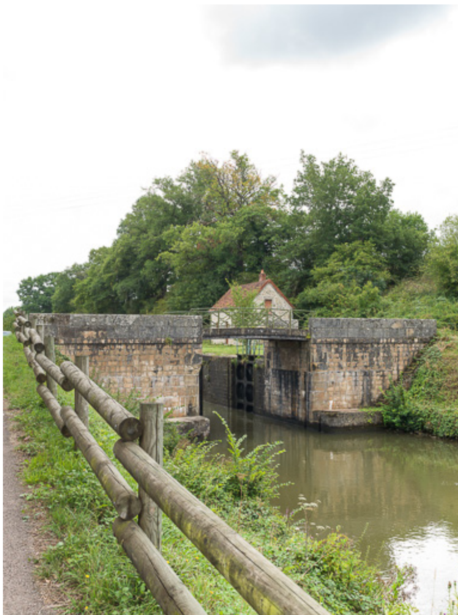
Vue d'ensemble du pont.
