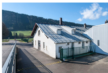
Partie sud du bâtiment originel (bureaux). Phot. Jérôme Mongreville IVR43_20162500311NUC4A
