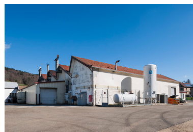
Extension sud de l'usine (1960). Phot. Jérôme Mongreville IVR43_20162500313NUC4A
