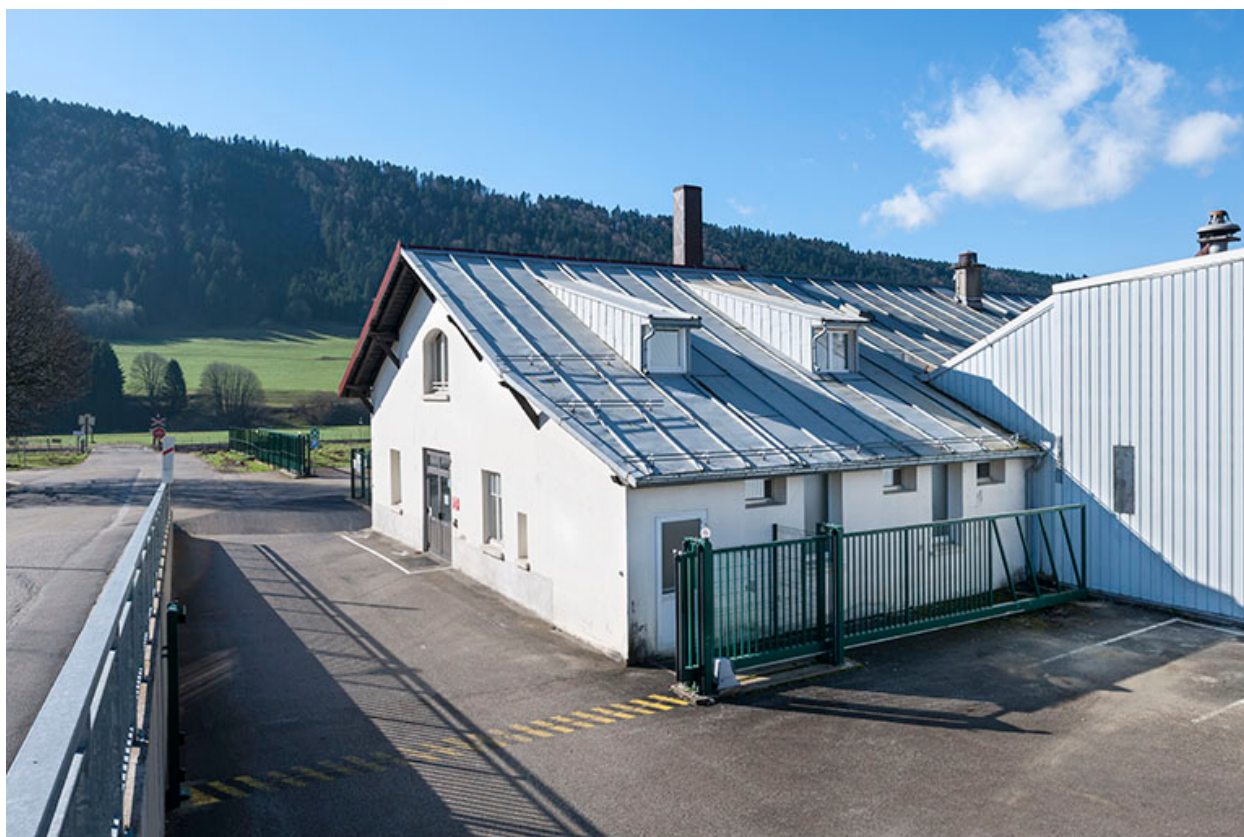
Partie sud du bâtiment originel (bureaux).
