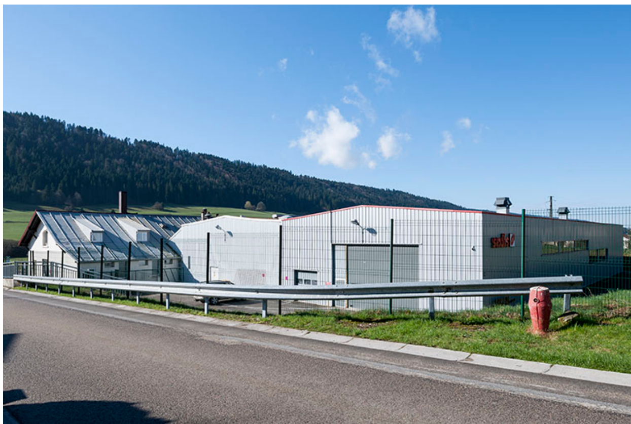
Vue depuis le nord-est.
