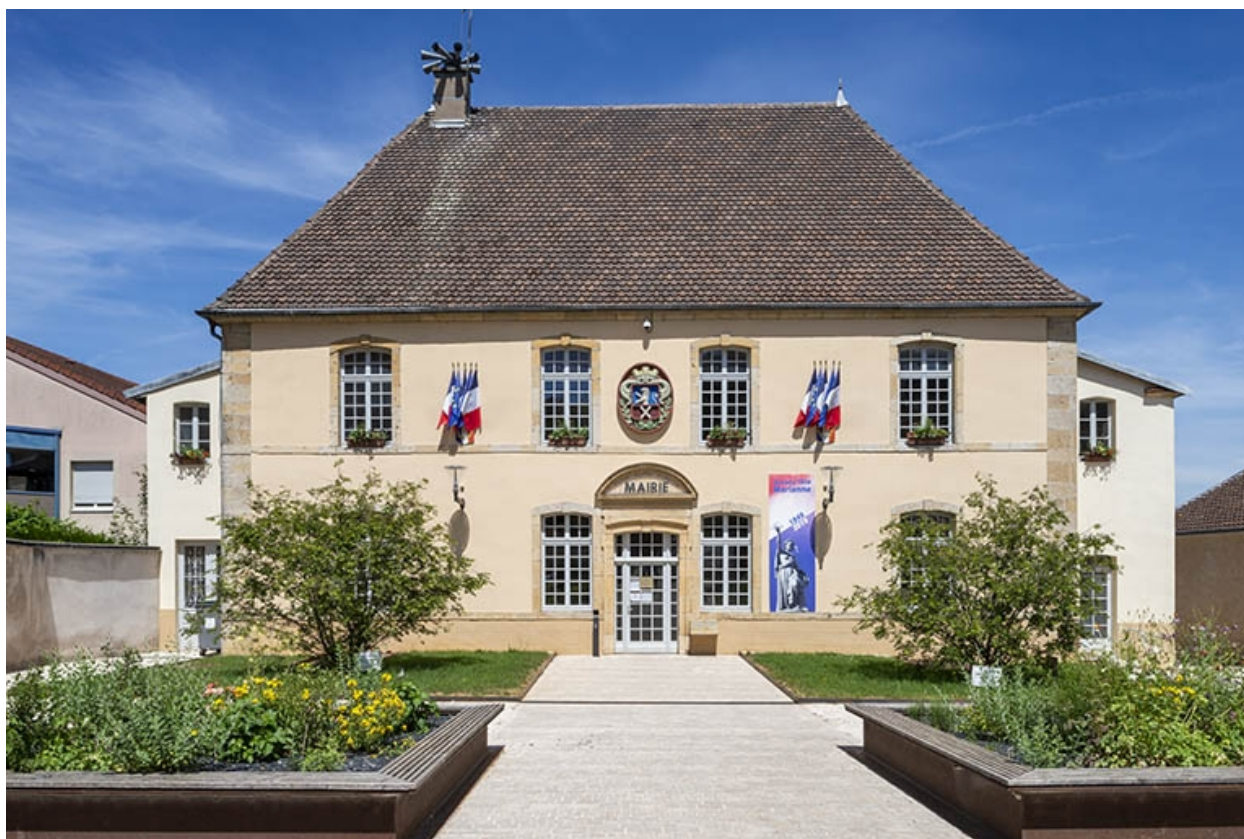
L'ensemble de la façade sud.
