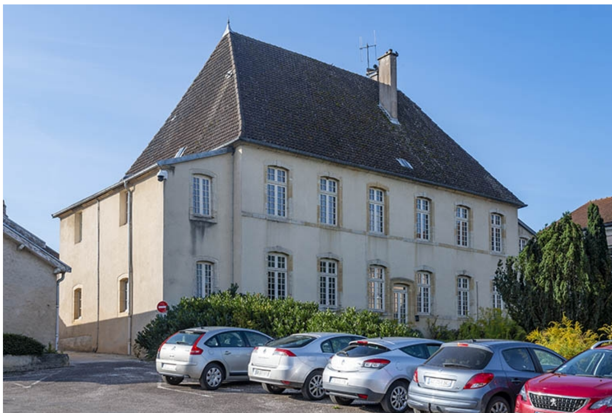
L'arrière, façade nord.
