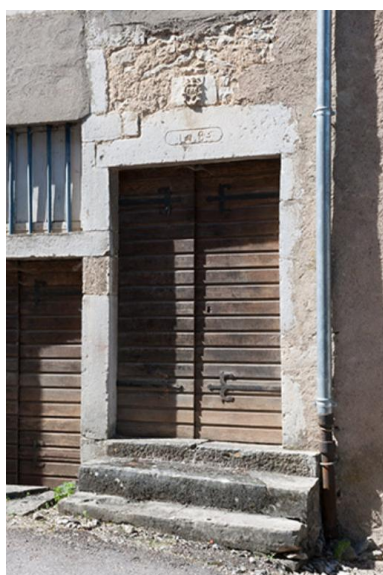
Détail de la porte datée 1785 Phot. Jérôme Mongreville IVR43_20137000214NUCA
