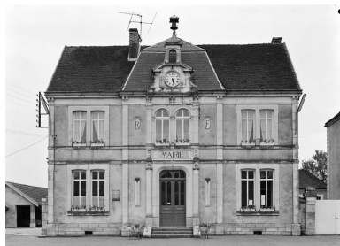
Façade sur la place. Phot. Michel Thierry IVR26_19748900116V
