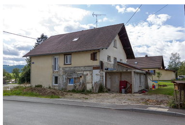
Bâtiment vu du nord. Phot. Sonia Dourlot IVR43_20142501852NUC2A
