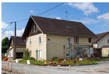
Vue d'ensemble, depuis le nord. Phot. Sonia Dourlot IVR43_20142501854NUC2A
