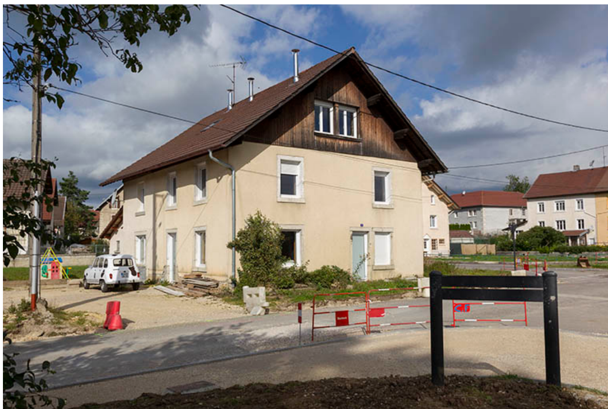
Bâtiment vu de l'est.
