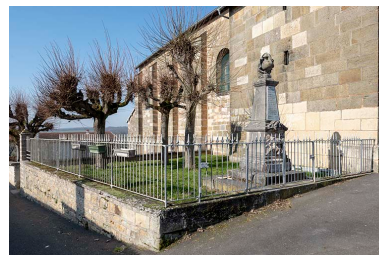
Plan rapproché de trois-quart de l'enclos du monument au mort sur le flanc gauche (sud) de l'édifice. Phot. Sonia Dourlot IVR43_20197000266NUC4A
