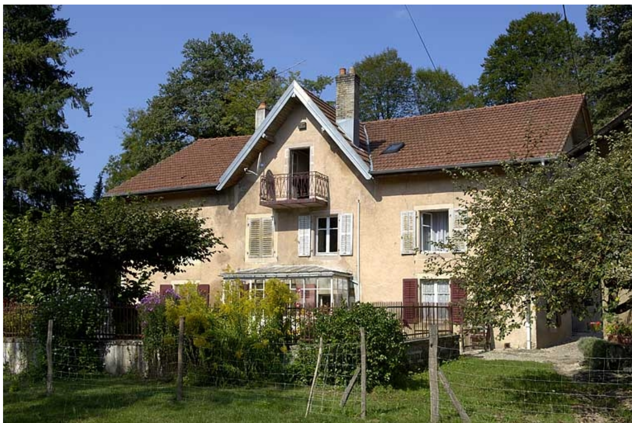
Façade sud du moulin.
