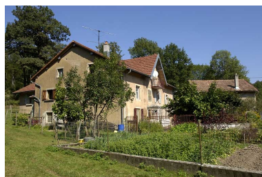
Le moulin vu de trois quarts. Phot. Jérôme Mongreville IVR43_20057000530NUCA
