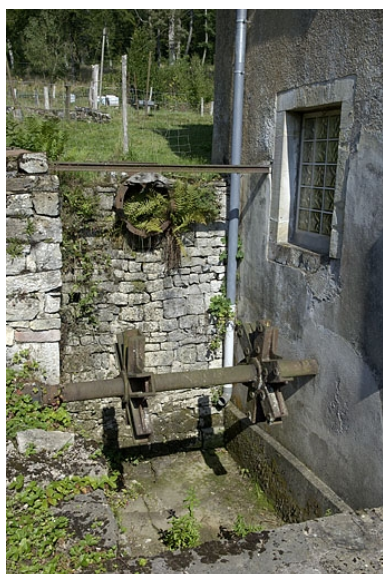
Emplacement de la roue hydraulique.
