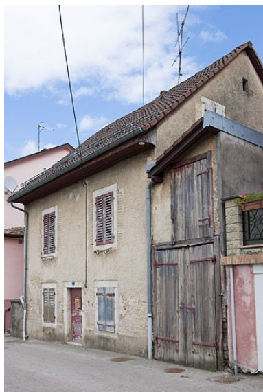
Détail d'une maison. Phot. Jérôme Mongreville IVR43_20122501012NUC4A
