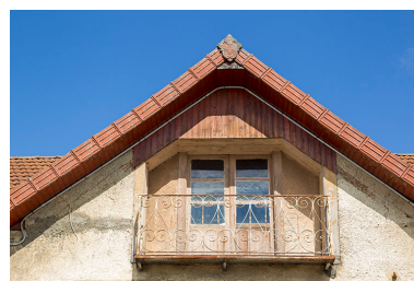
Façade antérieure : lucarne-pignon de l'étage en surcroît. Phot. Sonia Dourlot IVR43_20152500752NUC2A
