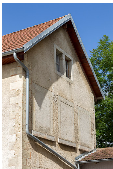
Mur pignon nord-est et ses fenêtres.
