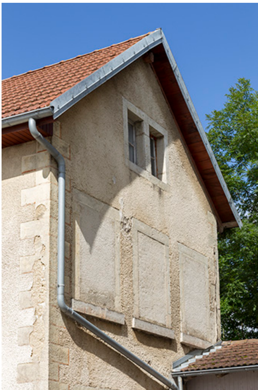
Mur pignon nord-est et ses fenêtres.
