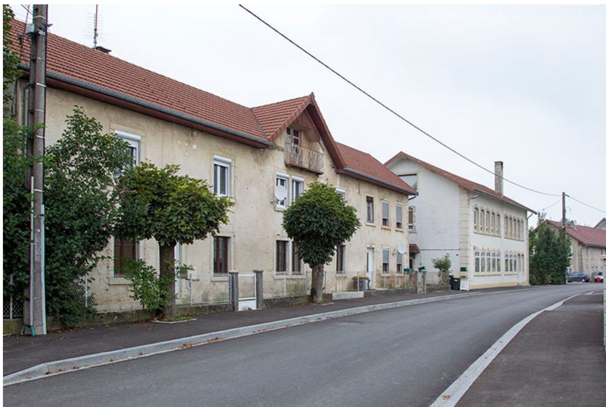
Vue d'ensemble, depuis le sud (façade antérieure).
