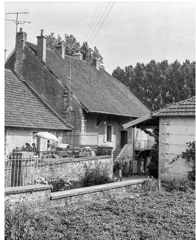
Messia-sur-Sorne : maison de vigneron située route de Courbouzon. Phot. Yves Sancey IVR43_19843900271X
