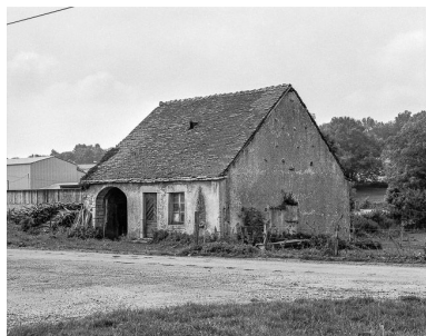
Bornay : ferme située rue Saint Néron. Phot. Yves Sancey IVR43_19843900065X
