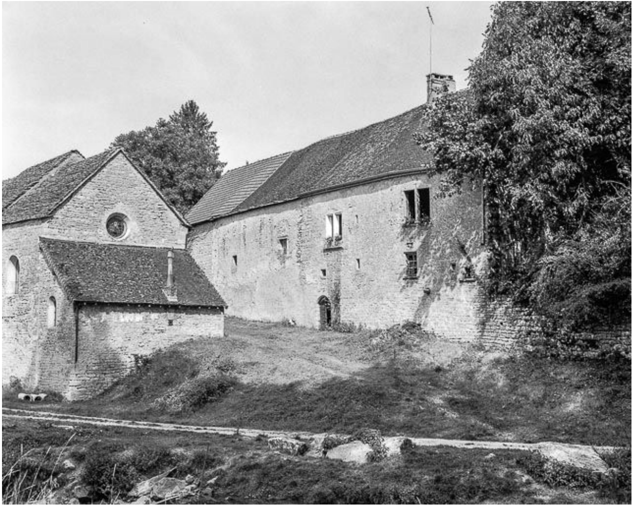
Maison Buffard située rue de l'Eglise.
