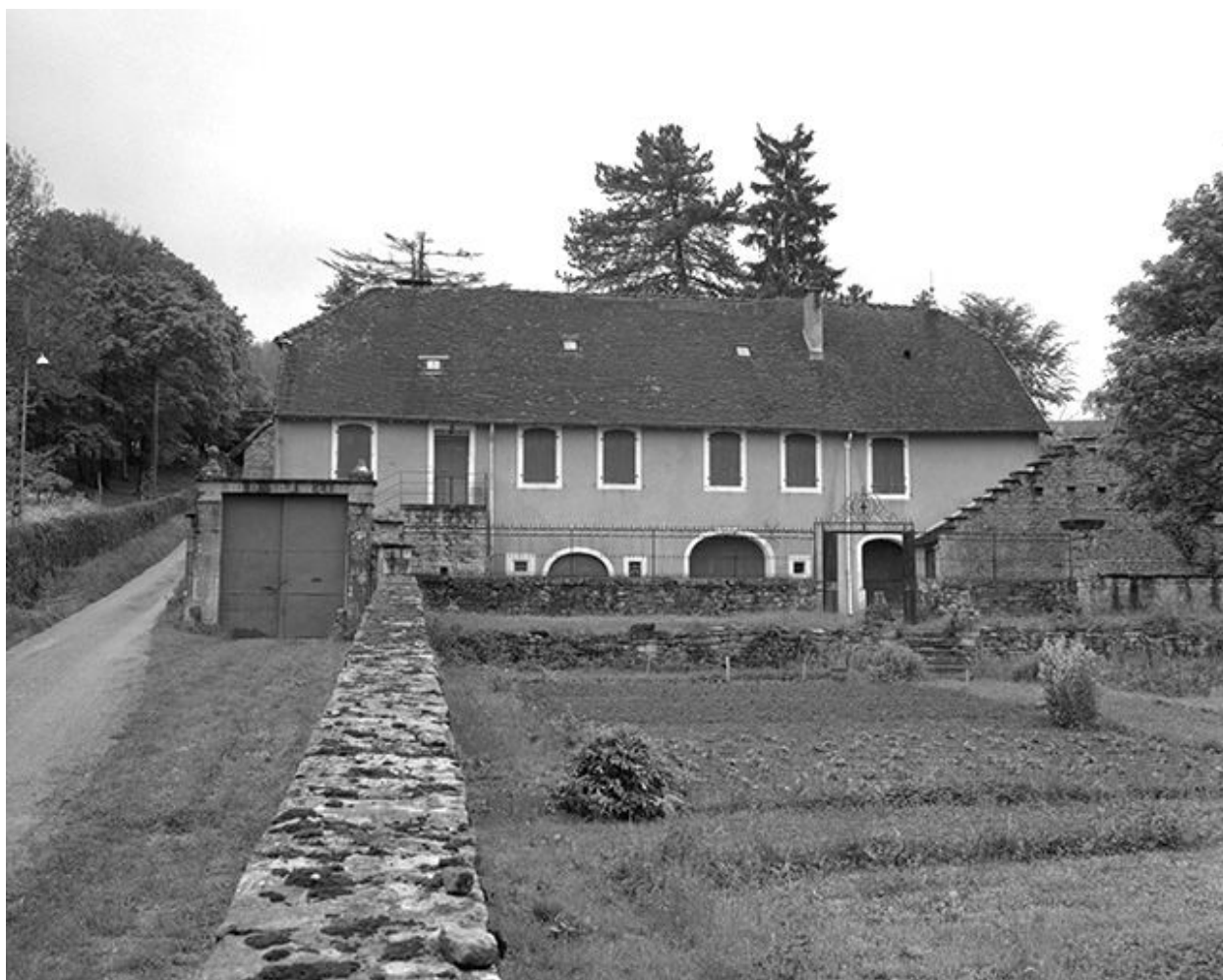
Moiron : maison de vigneron située rue de Farachat.
