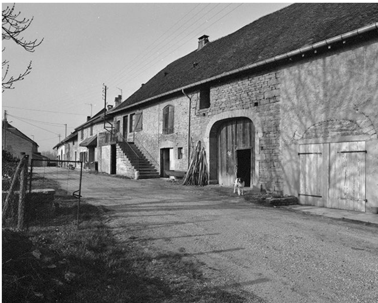
Geruge : ferme située rue du Puits.
