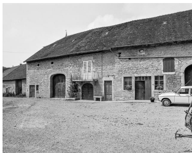
Bornay : ferme située rue Saint Néron. Phot. Yves Sancey IVR43_19843900060X
