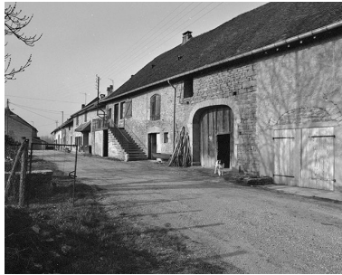
Geruge : ferme située rue du Puits. Phot. Jérôme Mongreville IVR43_19853900080X
