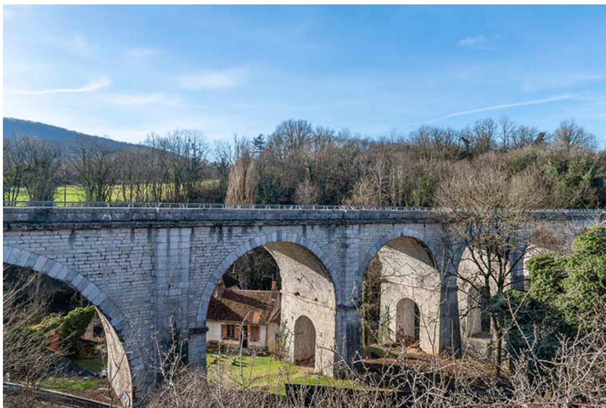
Vue de trois quarts, depuis le nord-est.
