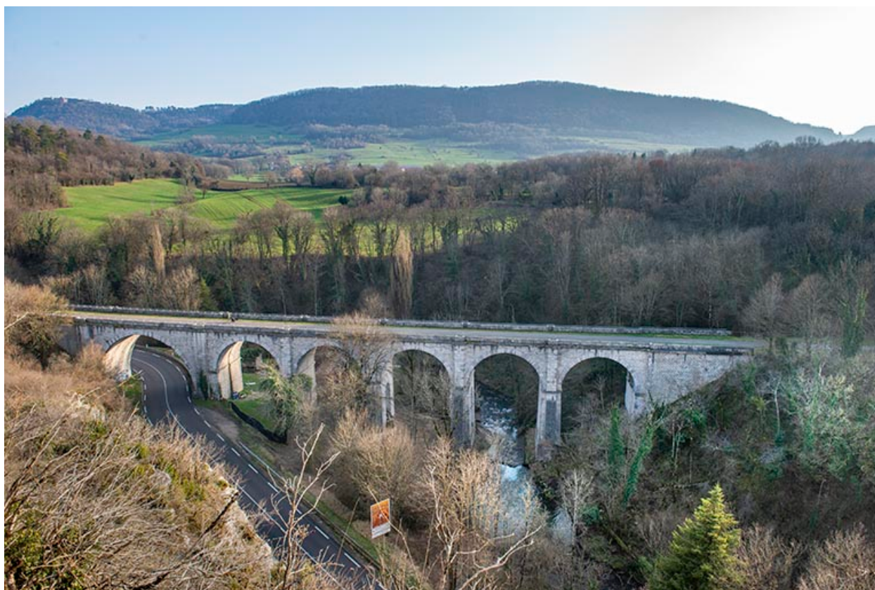
Vue d'ensemble, depuis le nord-ouest.
