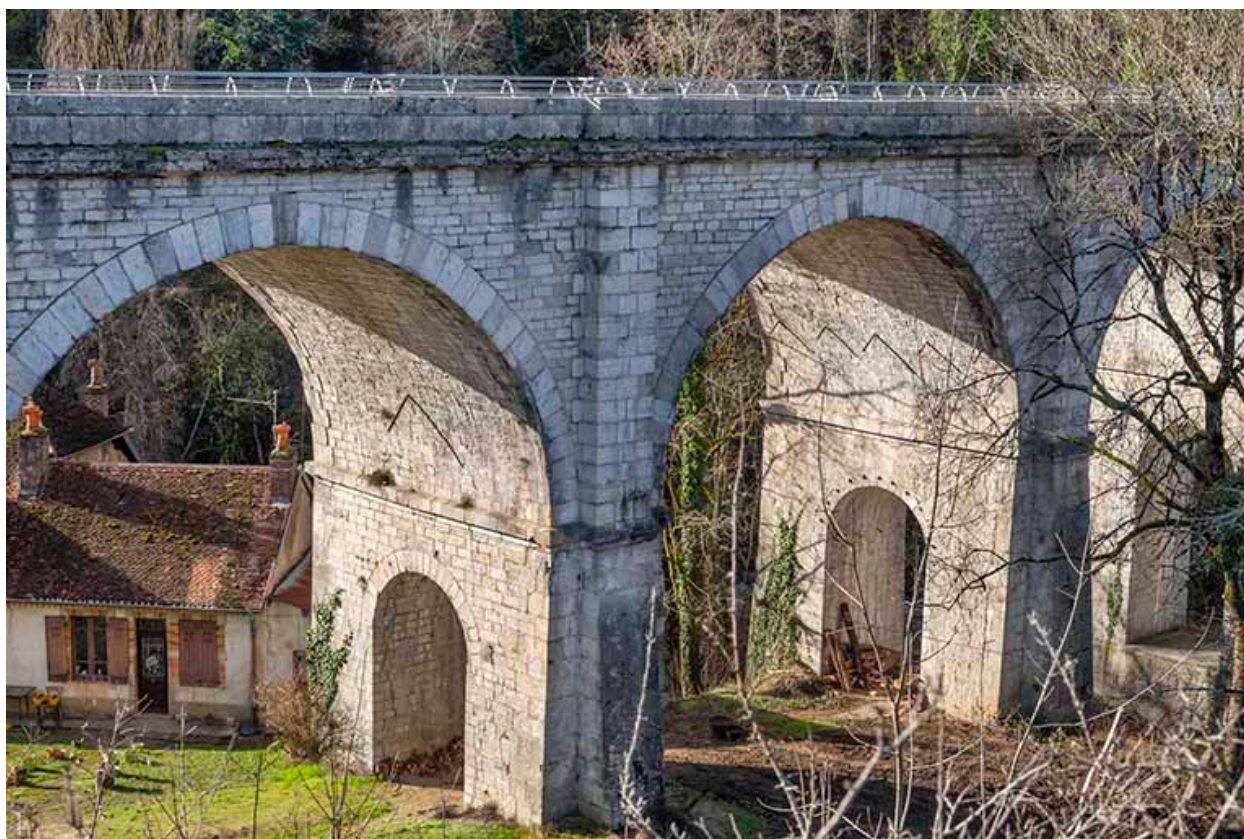
Vue sur les arches, depuis le nord-est.
