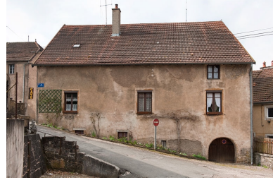
Façade latérale droite. Phot. Jérôme Mongreville IVR43_20102500379NUC4A
