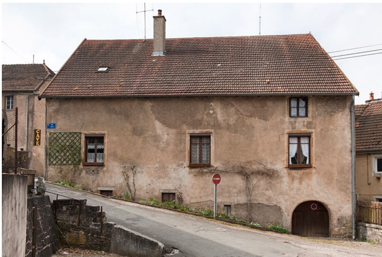
Façade latérale droite.
