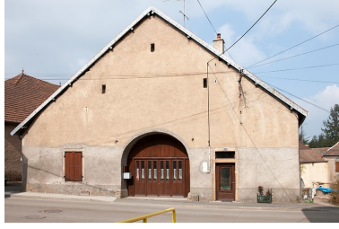
Façade antérieure. Phot. Jérôme Mongreville IVR43_20102500381NUC4A
