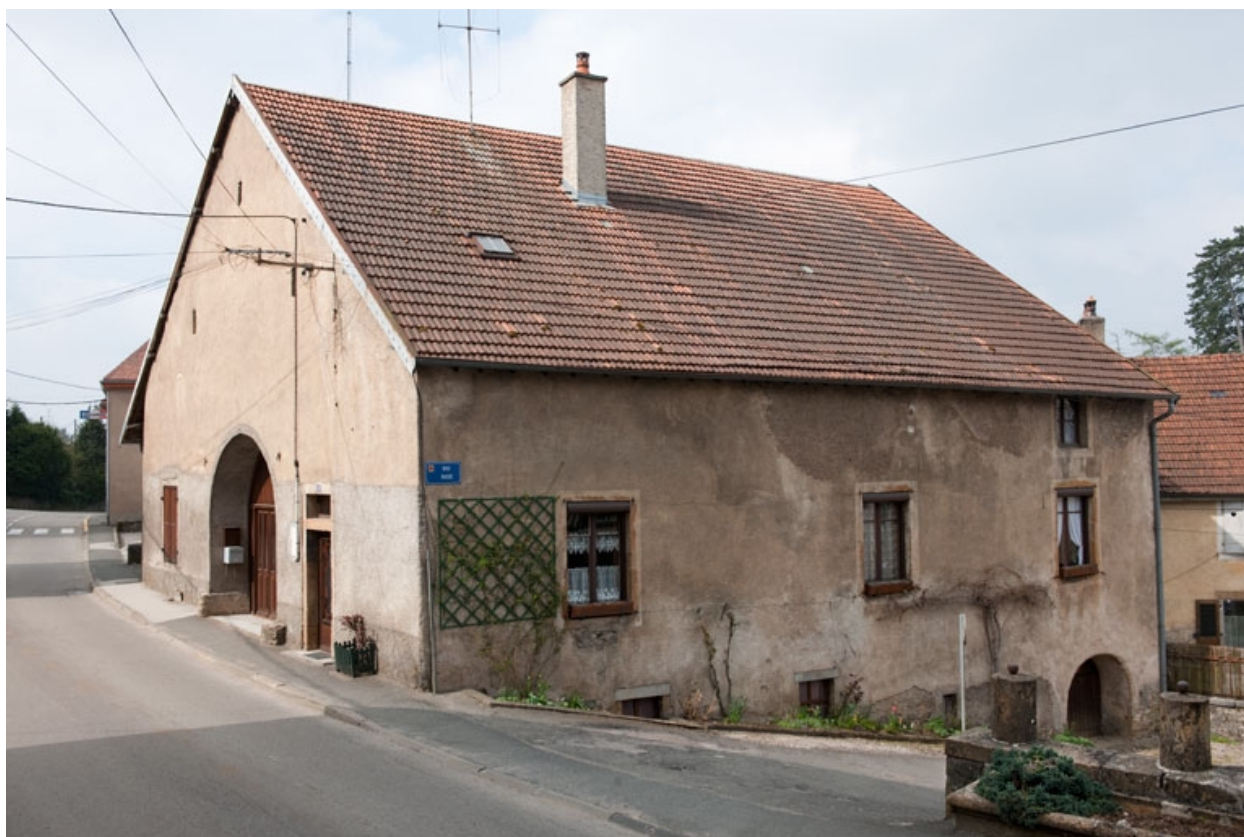
Façade antérieure et façade latérale droite.
