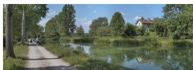
Maison de garde-barrière à droite.
