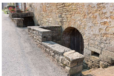
Accès aux caves. Phot. Jérôme Mongreville IVR43_20102501076NUC4A
