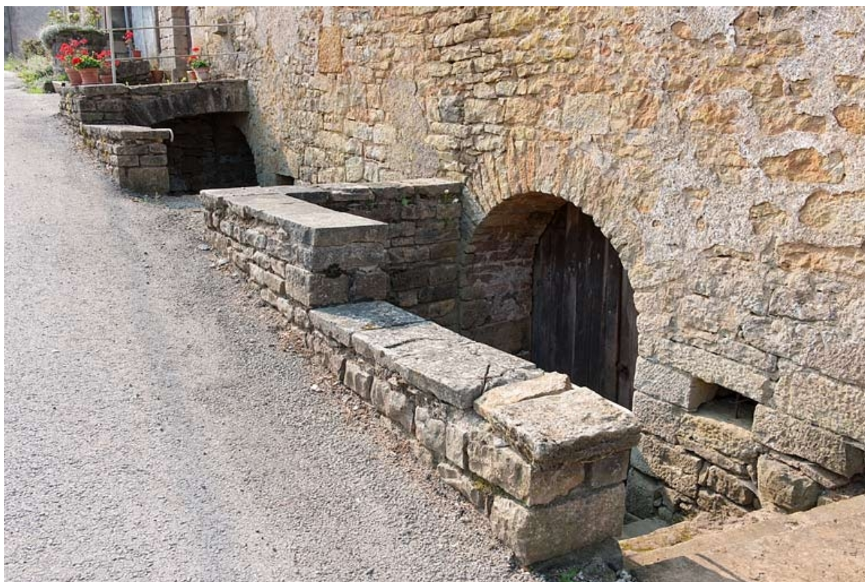
Accès aux caves.
