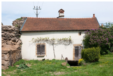
Façade postérieure. Phot. Jérôme Mongreville IVR43_20102500690NUC4A
