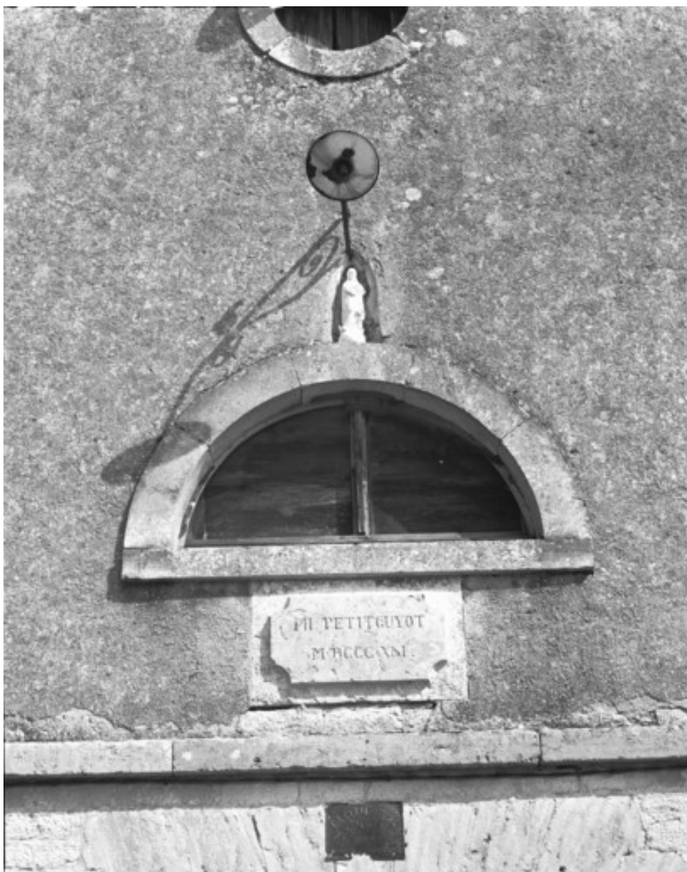
Détail du pignon du haut fourneau en 1989.
