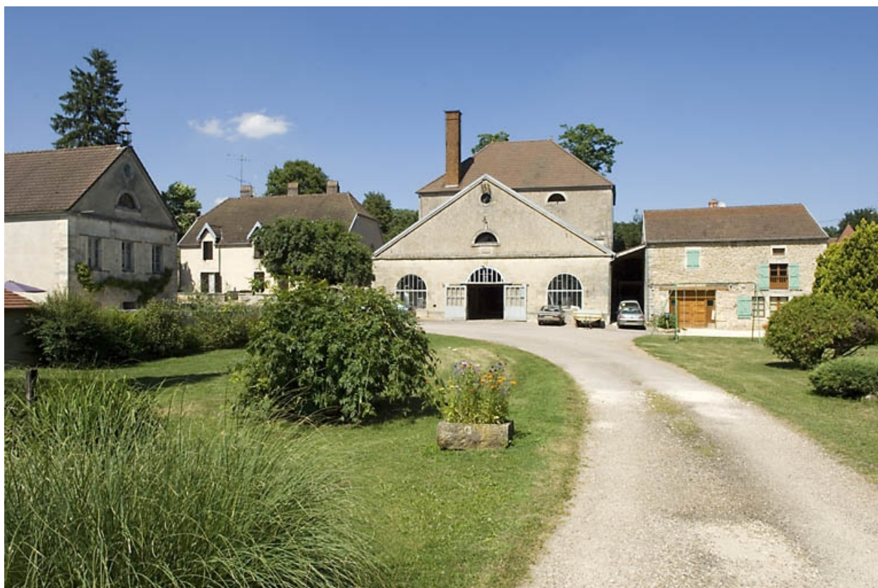
Vue d'ensemble depuis l'entrée, au sud.
