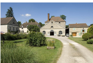
Vue d'ensemble depuis l'entrée, au sud. Phot. Jérôme Mongreville IVR43_20087000624NUC2A
