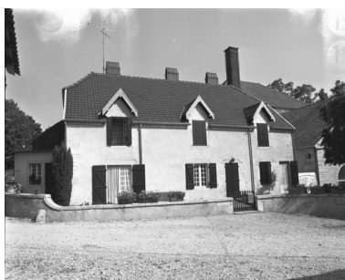
Logement patronal. Façade antérieure en 1989.
