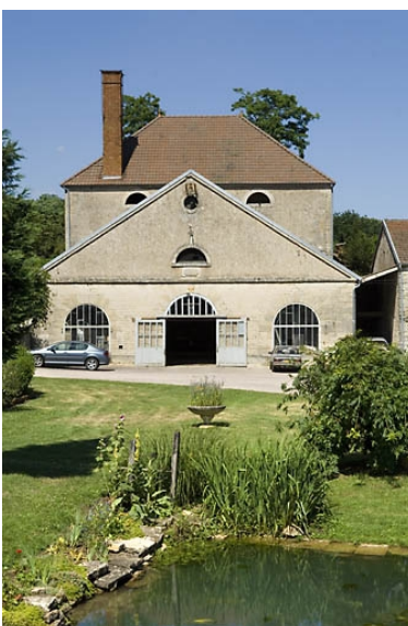
Le haut fourneau vu de face. Phot. Jérôme Mongreville IVR43_20087000625NUC2A
