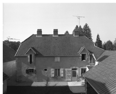
Logement patronal. Façade postérieure en 1989.
