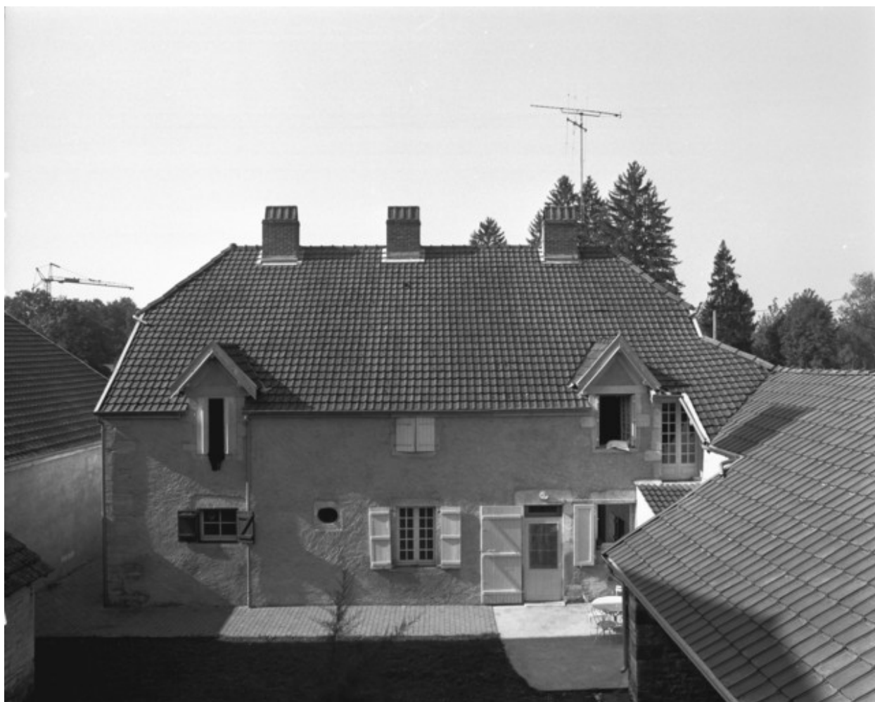
Logement patronal. Façade postérieure en 1989.
