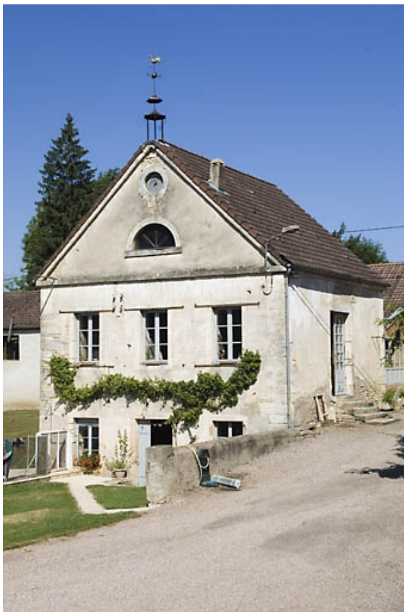
Bâtiment d'eau vu de trois quarts droite.
