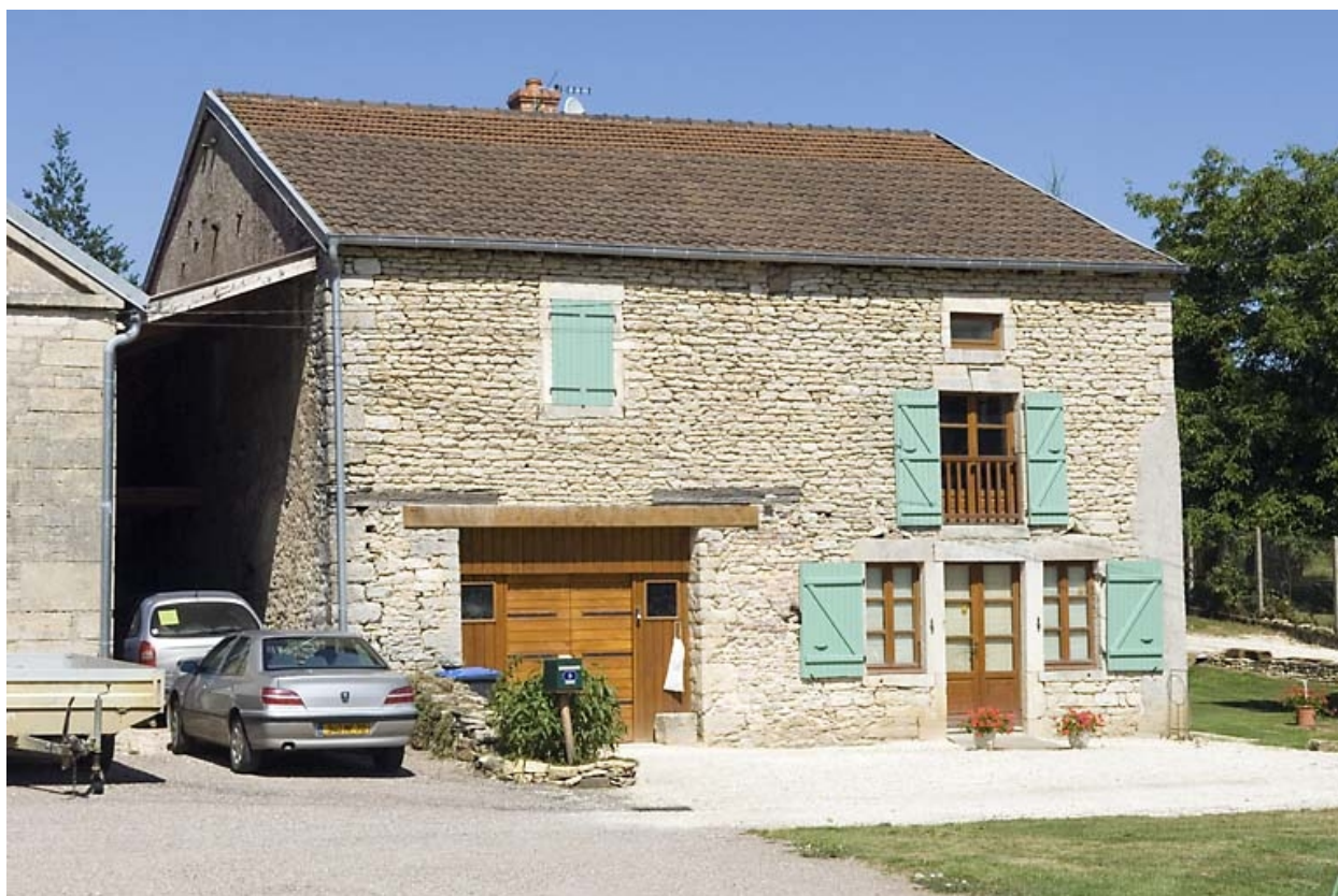
Remise et écurie converties en logement.
