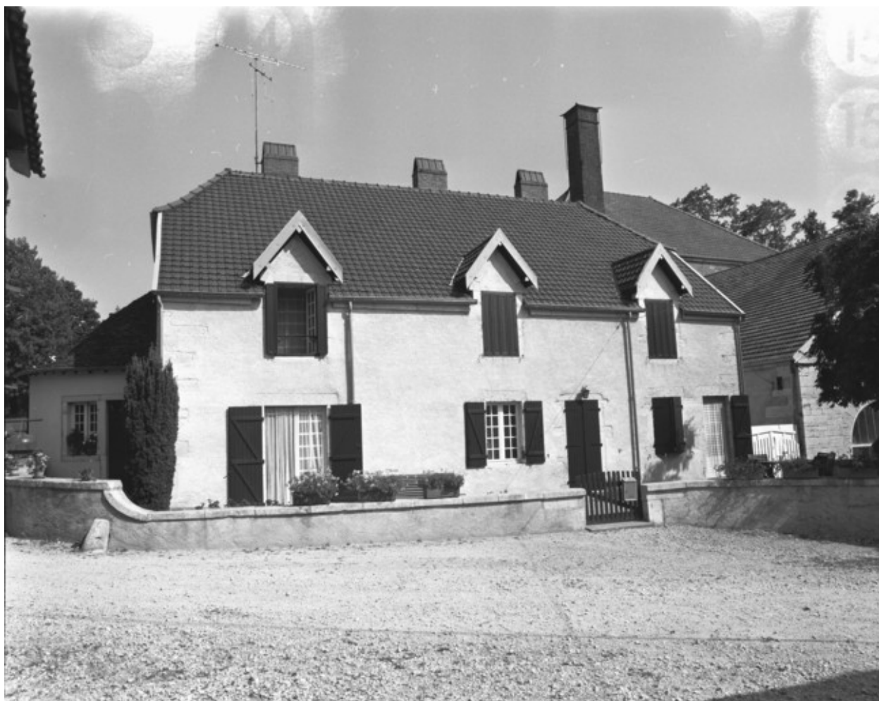
Logement patronal. Façade antérieure en 1989.
