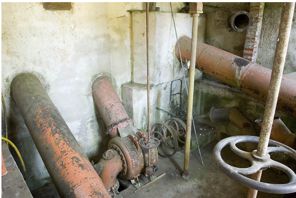
Intérieur du bâtiment d'eau.
