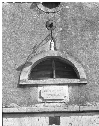
Détail du pignon du haut fourneau en 1989.
