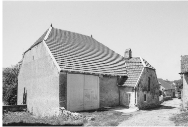
Le volume de grange. Phot. Bernard Lardière IVR43_19817000138Z
