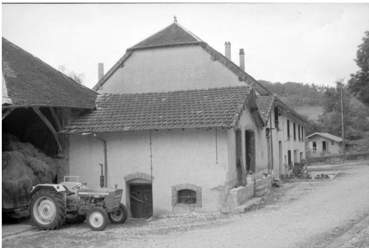
Bâtiment d'eau et atelier de fabrication.
