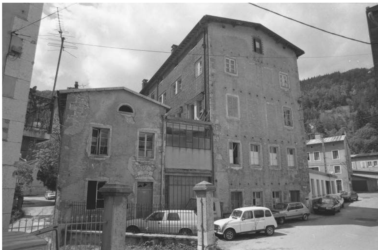
Bâtiment 6-8 rue Victor Poupin : façade latérale gauche.
