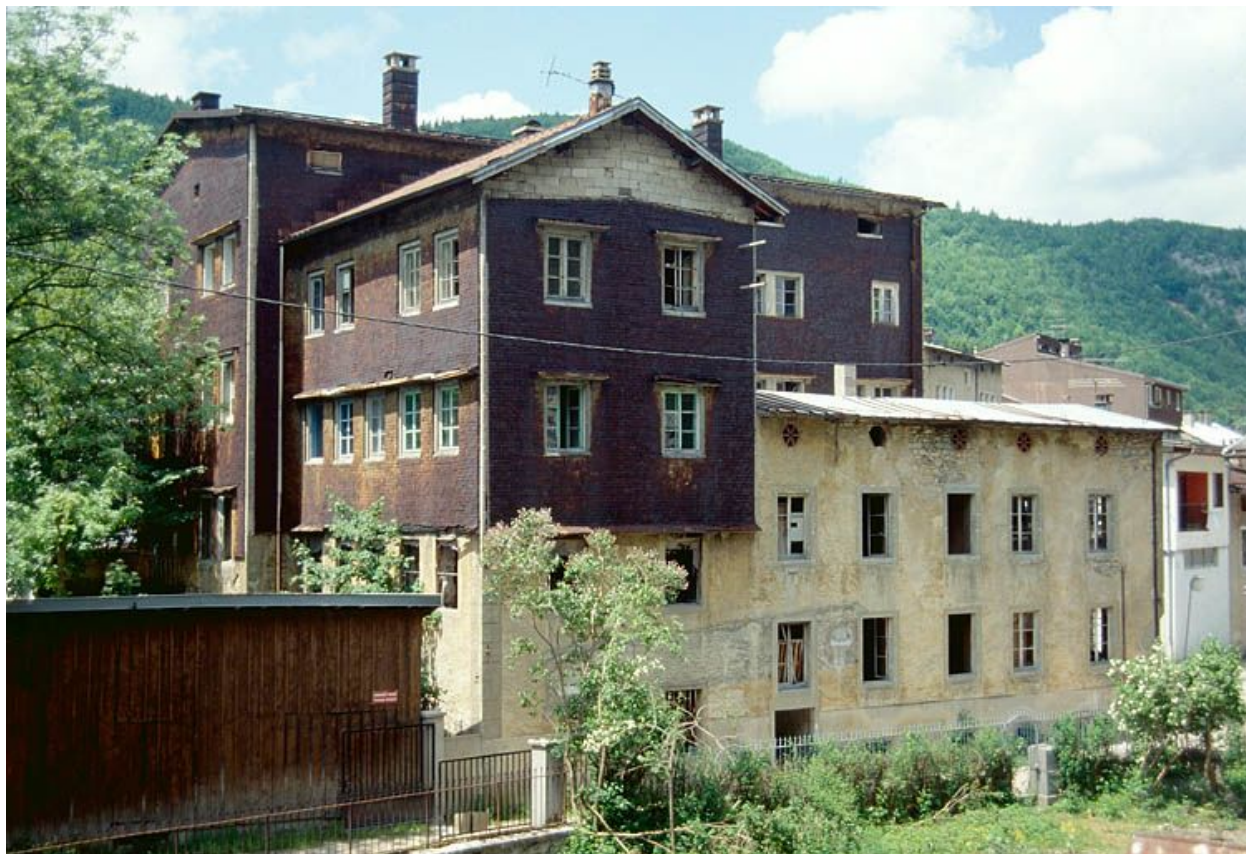
Bâtiment 6-8 rue Victor Poupin : façade postérieure.
