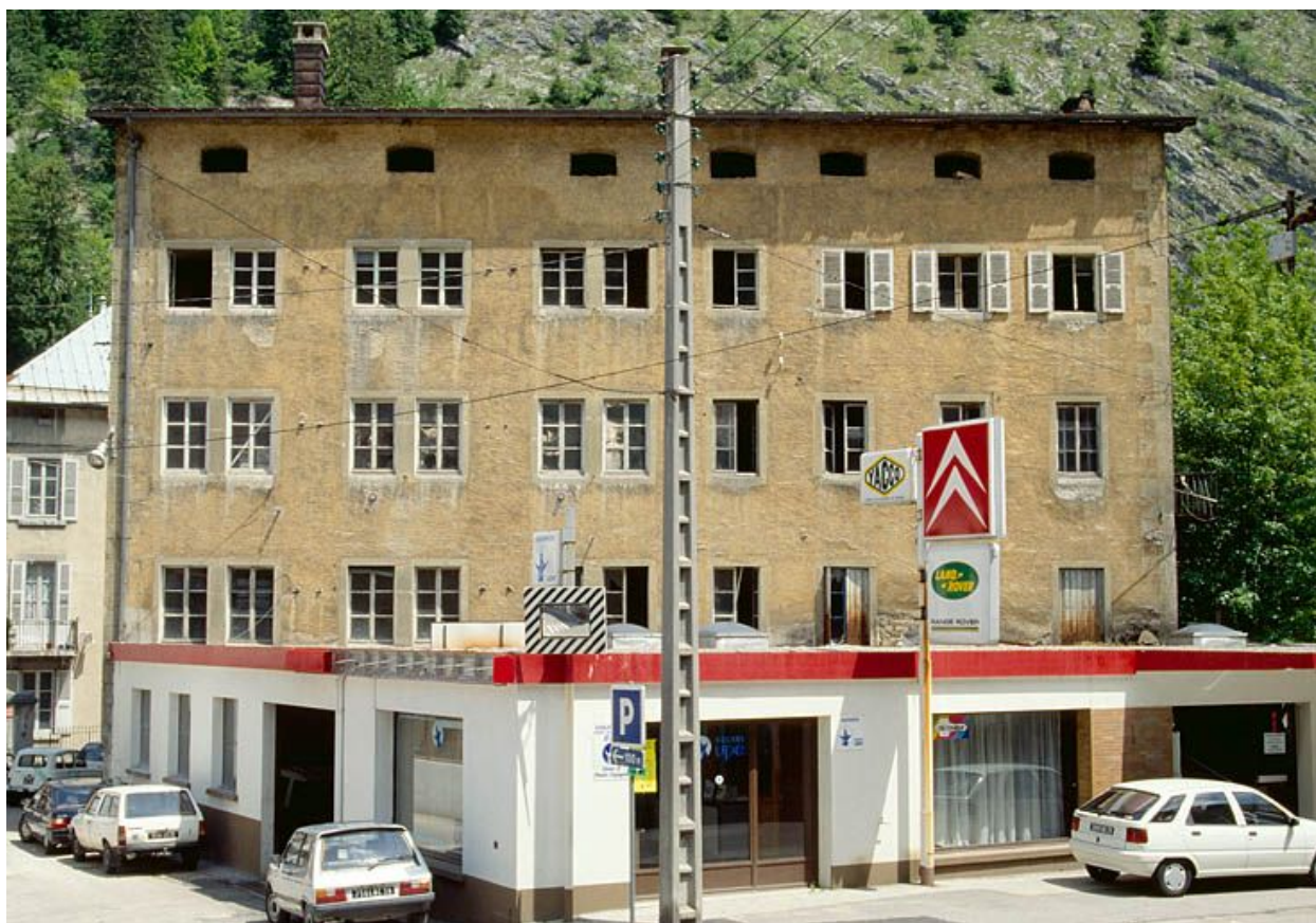
Bâtiment 6-8 rue Victor Poupin : façade antérieure.
