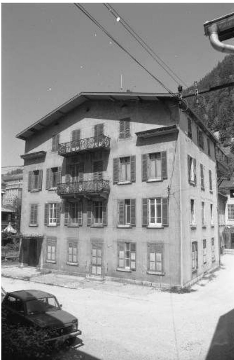
Logement patronal et anciens bureaux (1892) : façade antérieure.
