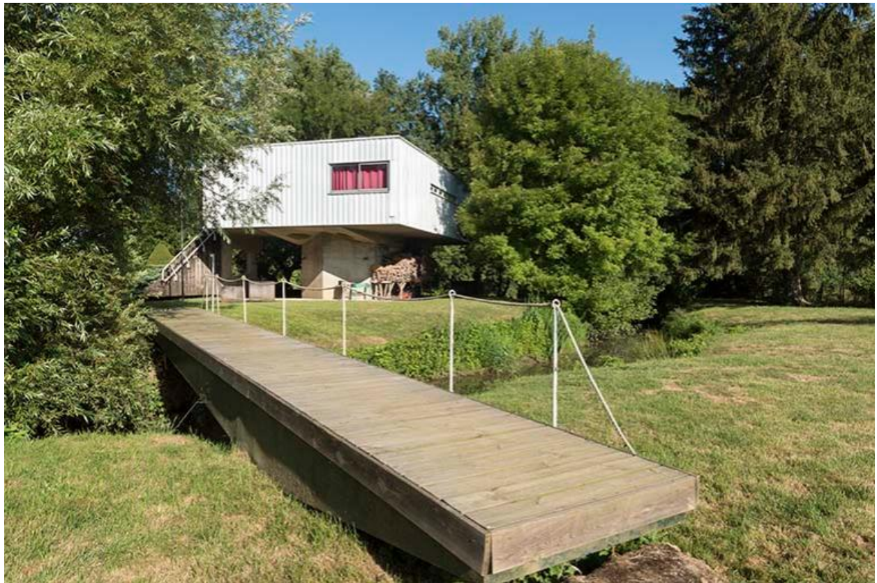
La villa et sa passerelle, angle sud-est
