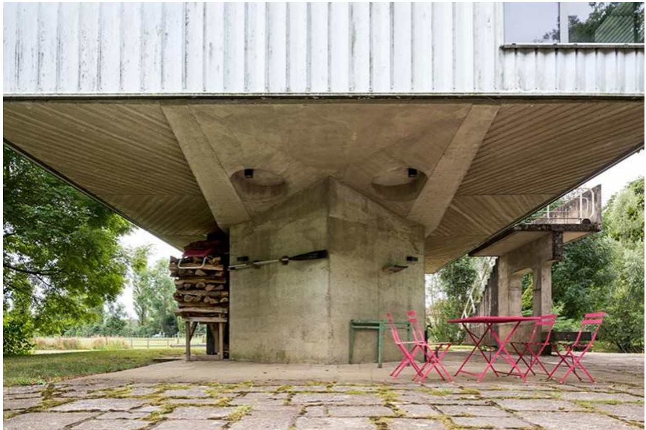
Vue de la pile et du soubassement avec alvéoles aménagées, façade nord
