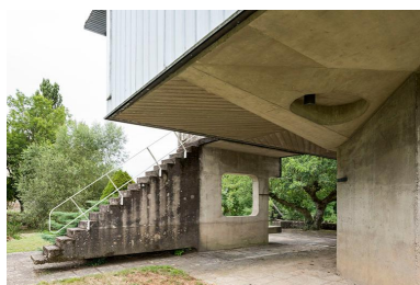
Côté sud, vue de l'escalier détaché du sol, de son mur porteur avec son ouverture et détail d'une alvéole aménagée sous la plateforme de la maison Phot. Sonia Dourlot IVR43_20167001329NUC4A
