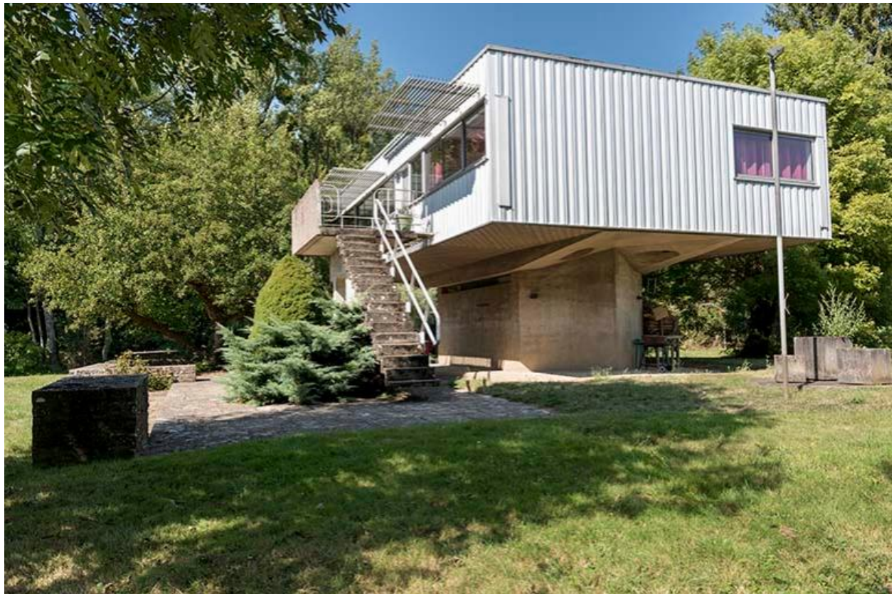
Villa, angle sud-ouest
