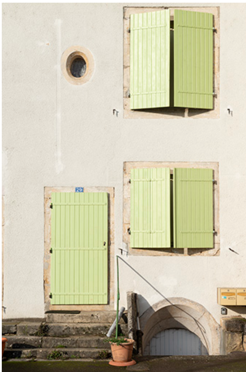
Vue partielle de la façade antérieure.
