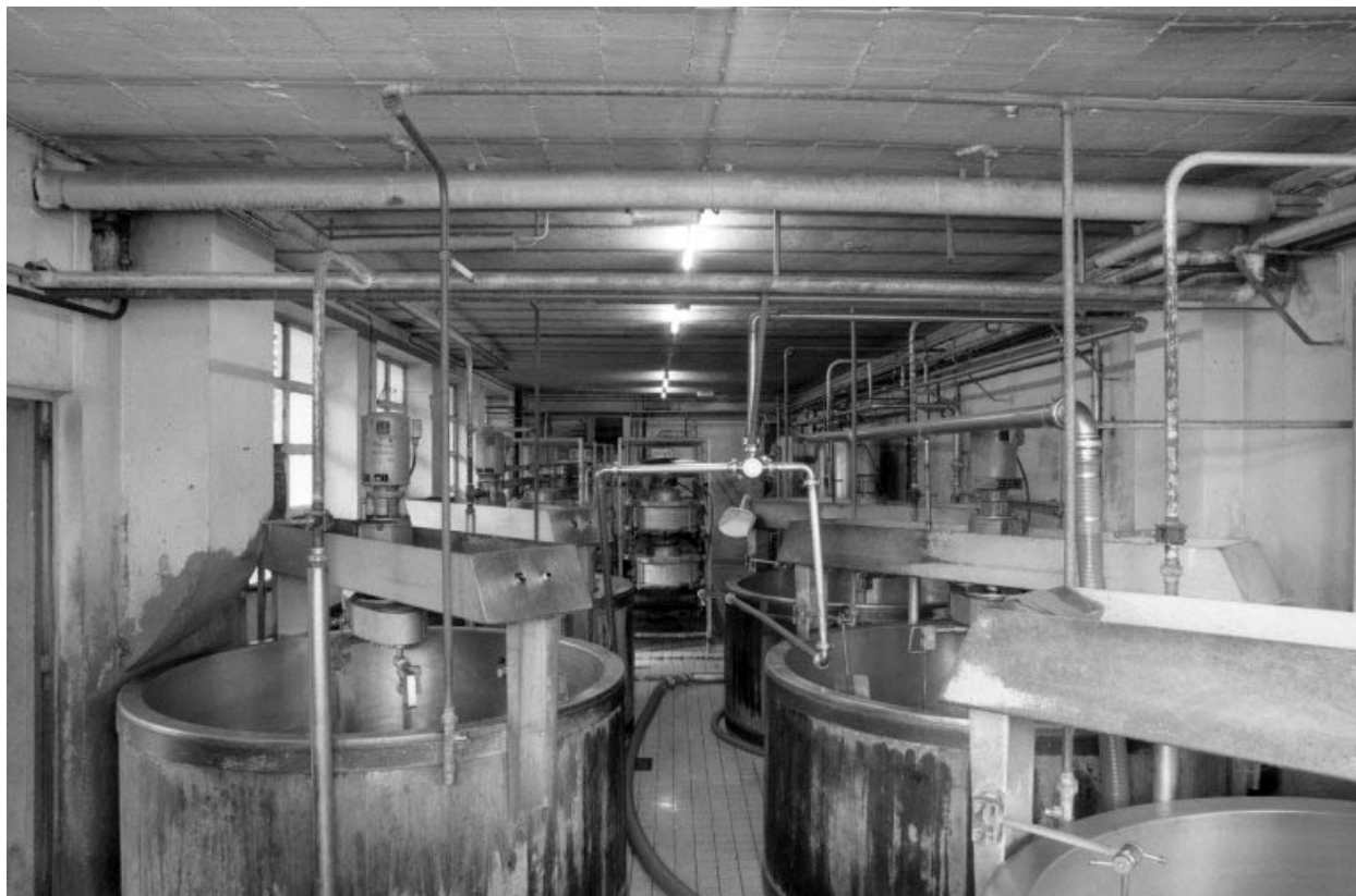
Intérieur de l'atelier de fabrication.
