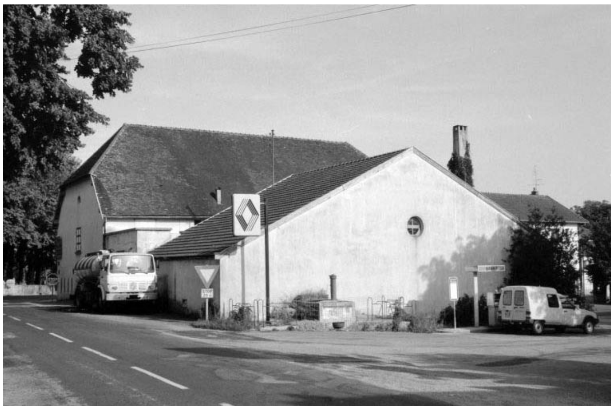
Fromagerie et pièce d'affinage vues du nord-ouest.
