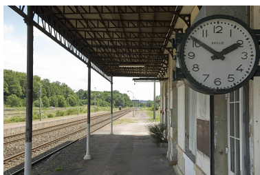
Bâtiment des voyageurs, détail : la pendule Brillié. Phot. Marc Loukachine IVR43_20127000183NUC2A
