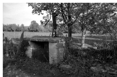
Vue du puits. Phot. Bernard Lardière IVR43_19797000059Z
