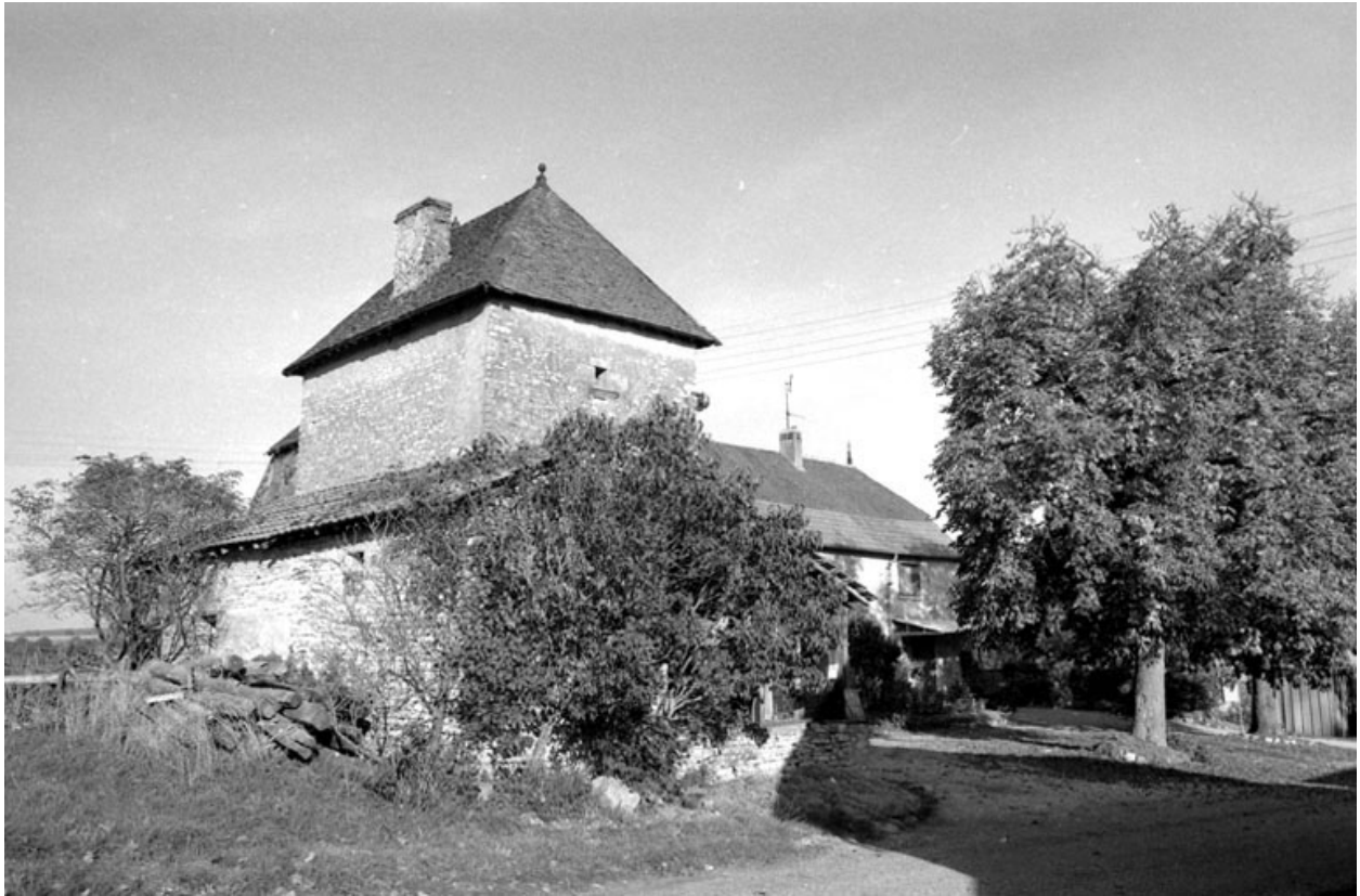
Partie habitation : face latérale gauche.
