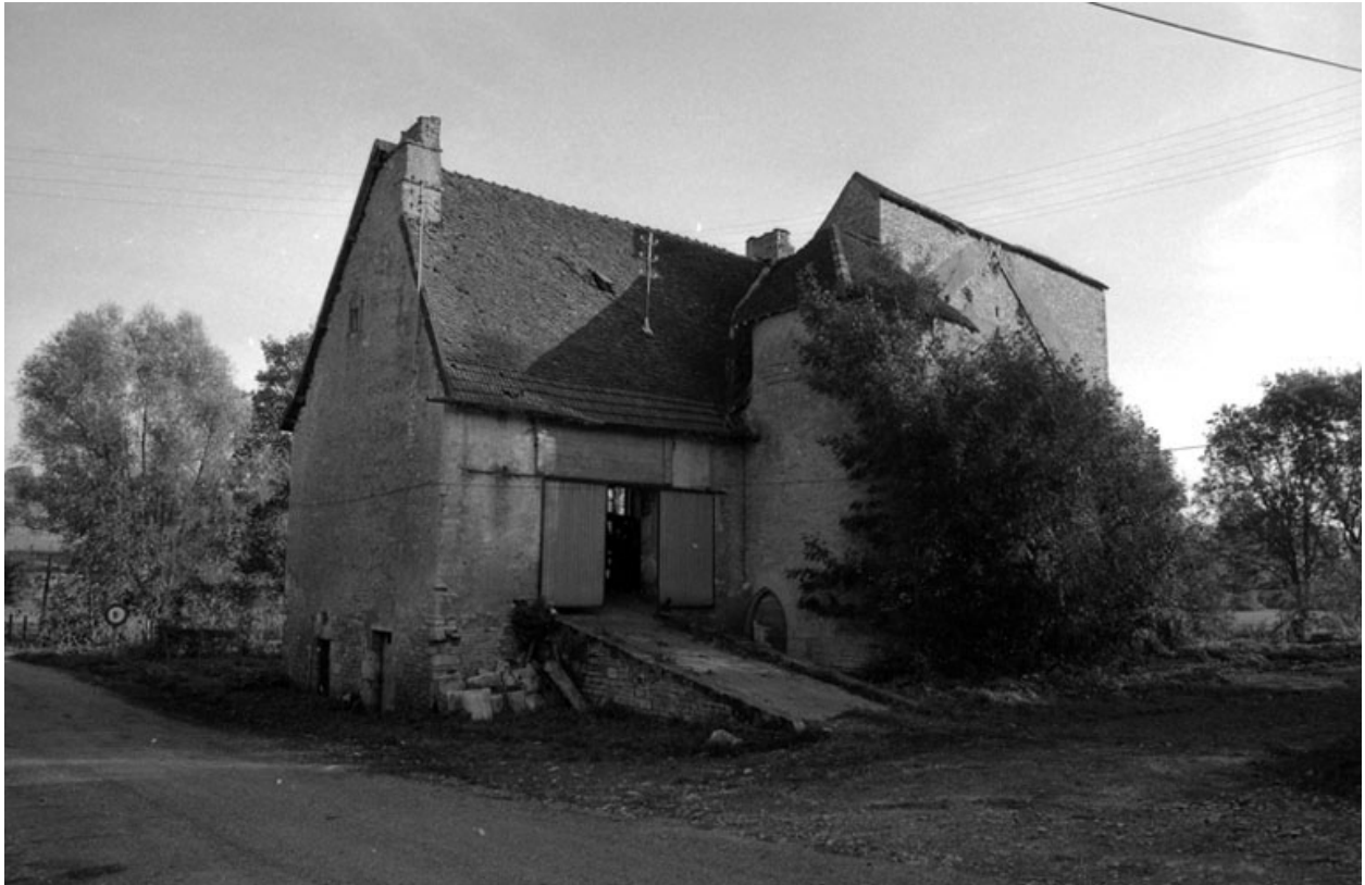
Partie agricole : façade antérieure.
