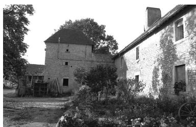
Partie d'habitation : vue d'ensemble. Phot. Bernard Lardière IVR43_19797000061Z
