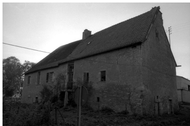
Partie agricole : façade postérieure. Phot. Bernard Lardière IVR43_19797000057Z
