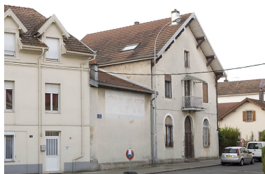
Logement patronal. Vue de trois quarts. Phot. Jérôme Mongreville IVR43_20077000636NUCA
