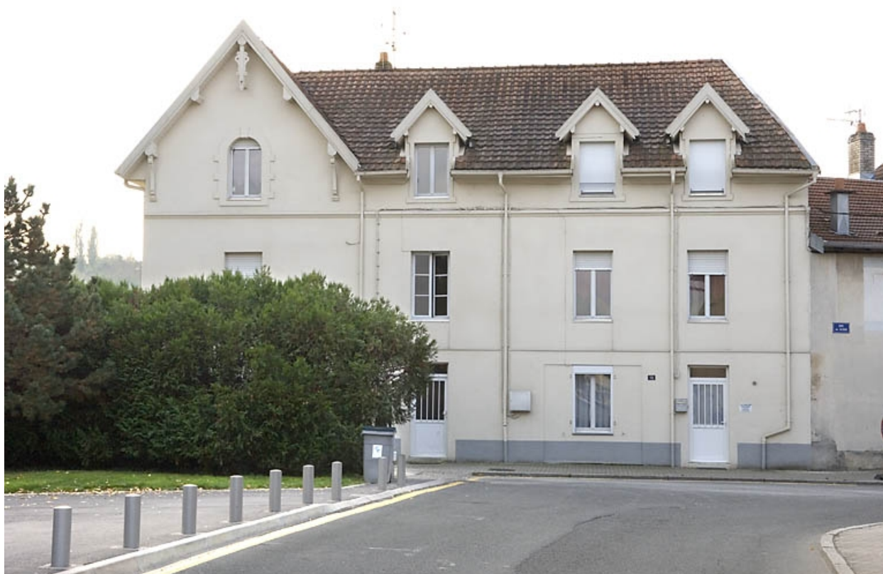
Logement ouvrier (?). Vue de face.
