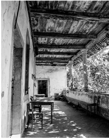
Corps de logis, étage de la galerie. Phot. Dominique Dominguez IVR43_19773900040X
