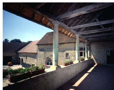
Galerie ouverte du premier étage. Phot. Yves Sancey IVR43_19903901163VA
