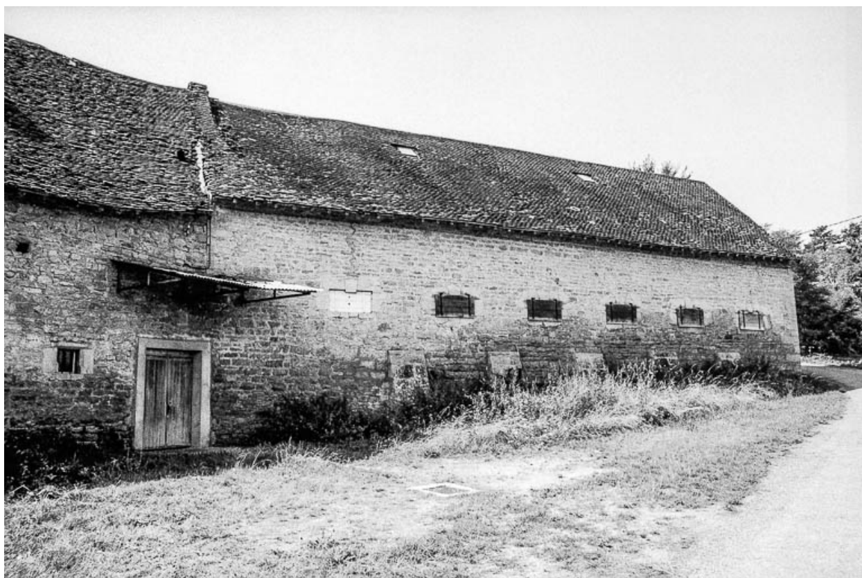
Partie agricole : façade sur la rue.
