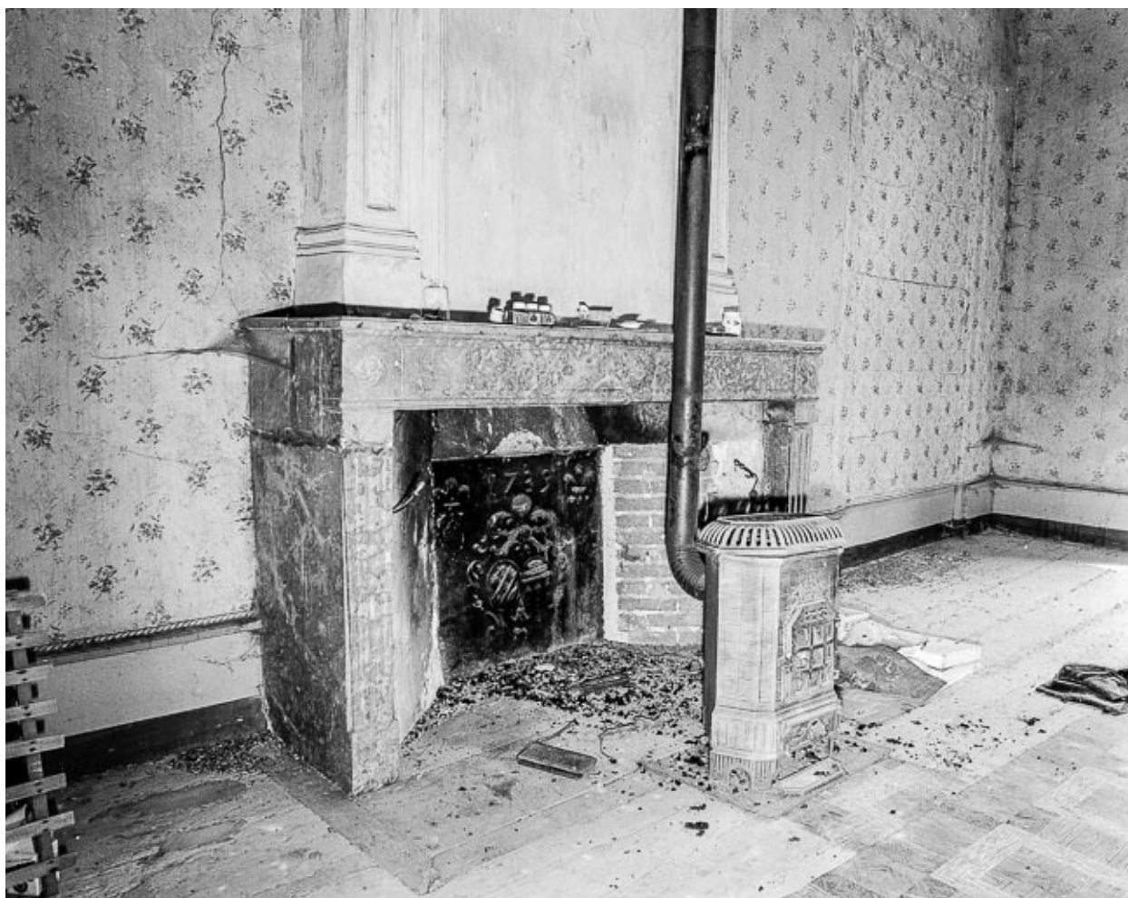
Corps de logis, cheminée.
