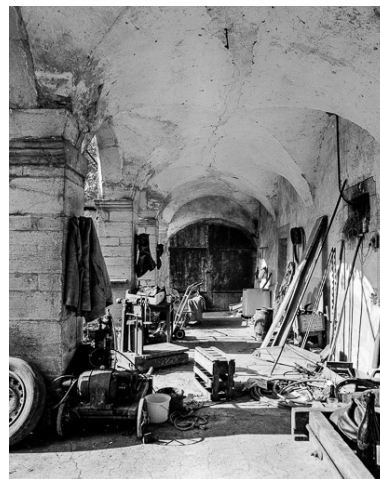
Corps de logis, rez-de- chaussée de la galerie. Phot. Dominique Dominguez IVR43_19773900038X
