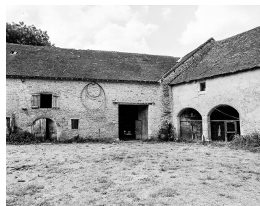
Partie agricole : façade sur cour. Phot. Dominique Dominguez IVR43_19773900034X
