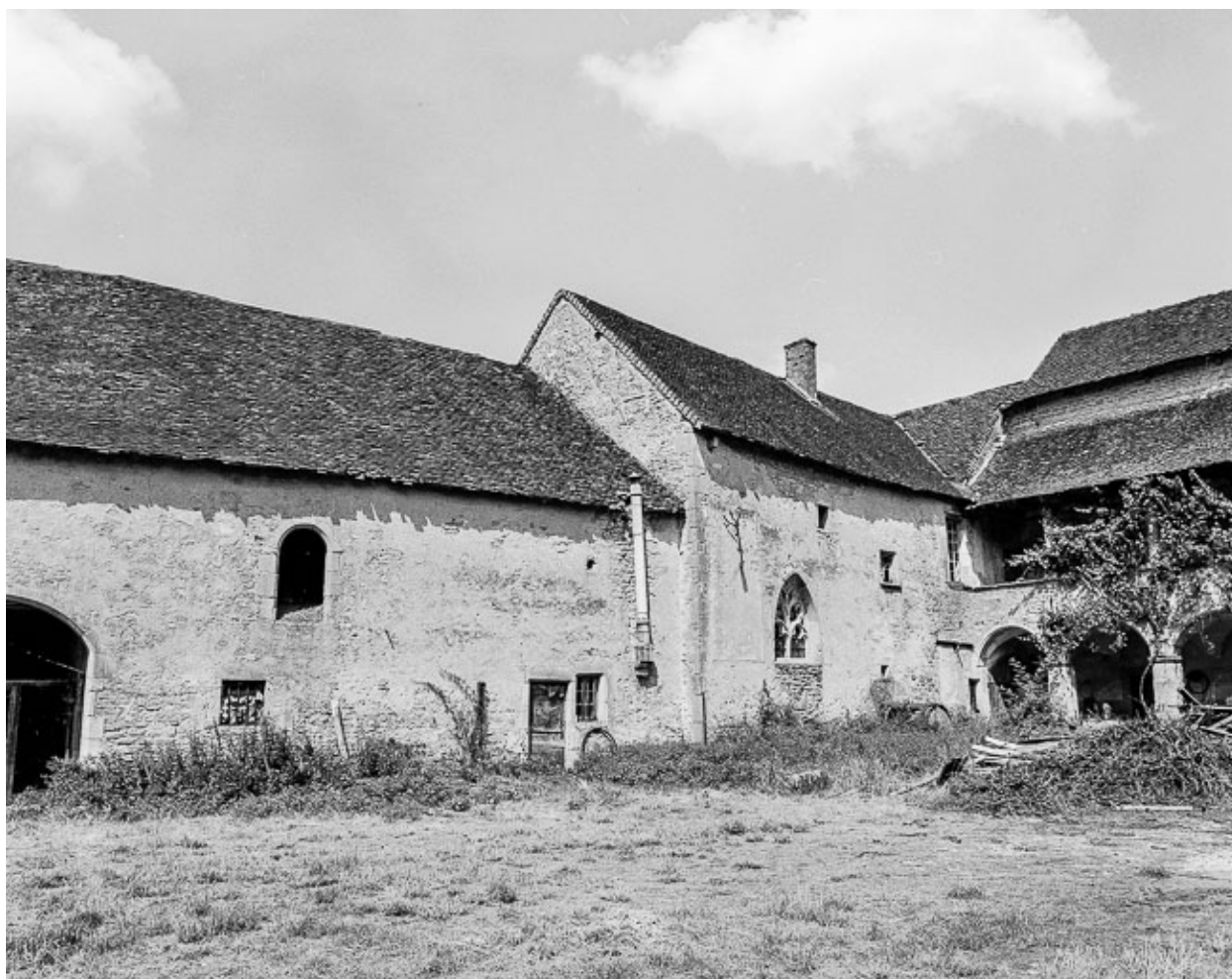
Chapelle, élévation sur cour.
