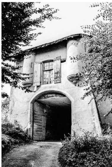
Porche d'entrée. Phot. Bernard Pontefract IVR43_19753900385Z
