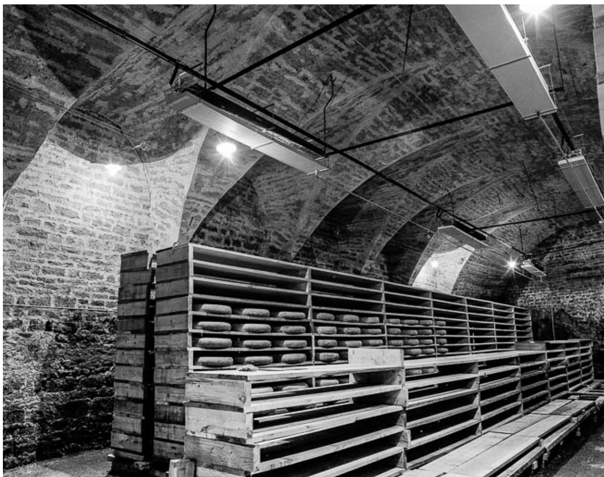
Partie agricole : cave, mur gauche.
