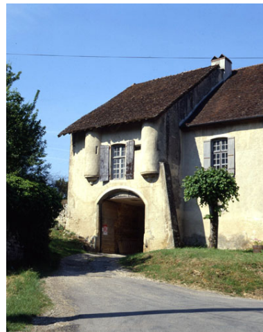
Bâtiment d'entrée : porche et façade latérale gauche. Phot. Yves Sancey IVR43_19903901161XA
