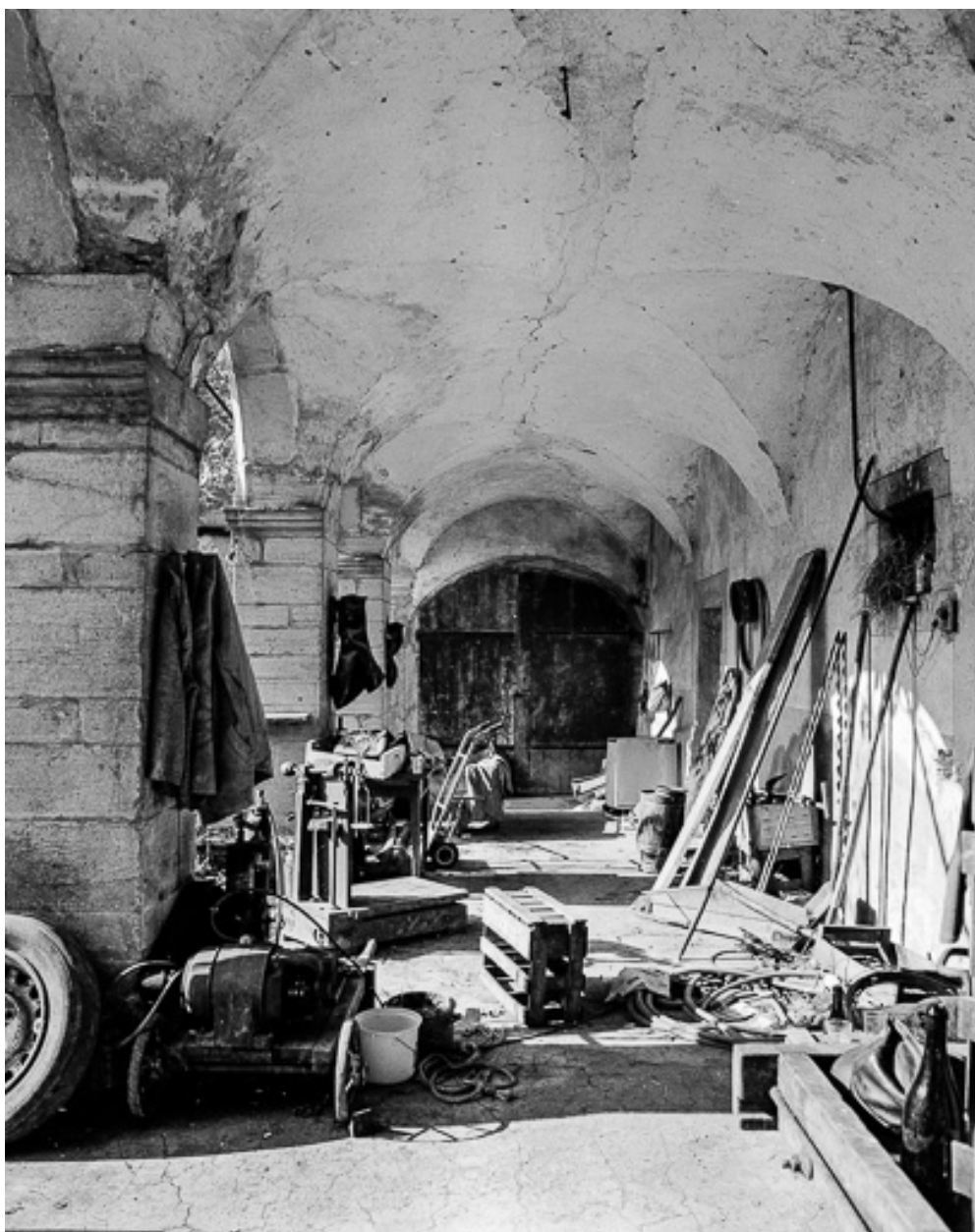
Corps de logis, rez-de-chaussée de la galerie.
