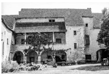
Corps de logis : la galerie. Phot. Bernard Pontefract IVR43_19753900376Z
