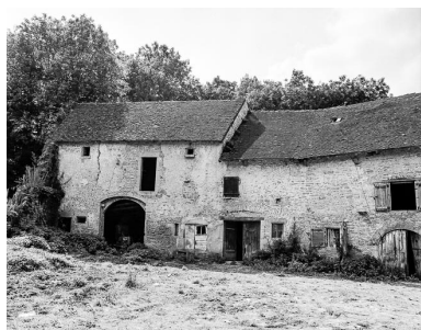
Partie agricole : façade sur cour. Phot. Dominique Dominguez IVR43_19773900033X
