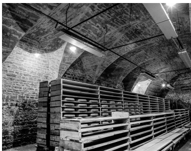
Partie agricole : cave, mur gauche.
