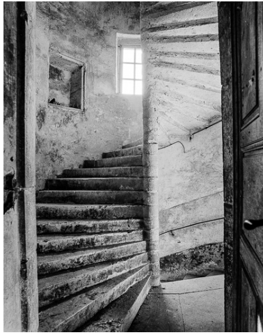
Corps de logis, l'escalier. Phot. Dominique Dominguez IVR43_19773900039X
