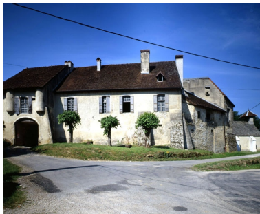
Façade antérieure. Phot. Yves Sancey IVR43_19903901160VA
