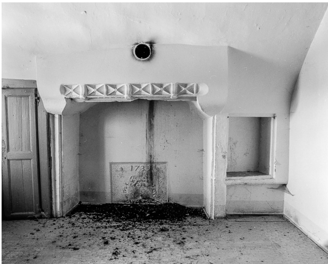
Corps de logis, cheminée.
