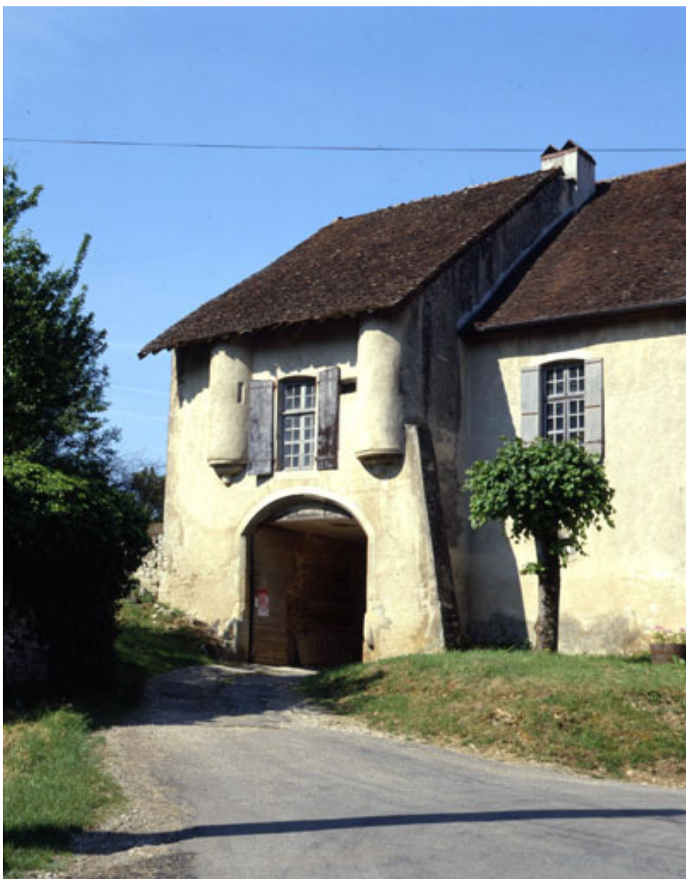
Bâtiment d'entrée : porche et façade latérale gauche.
