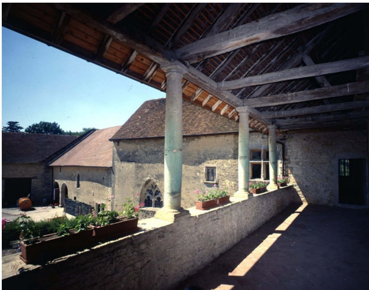
Galerie ouverte du premier étage.
