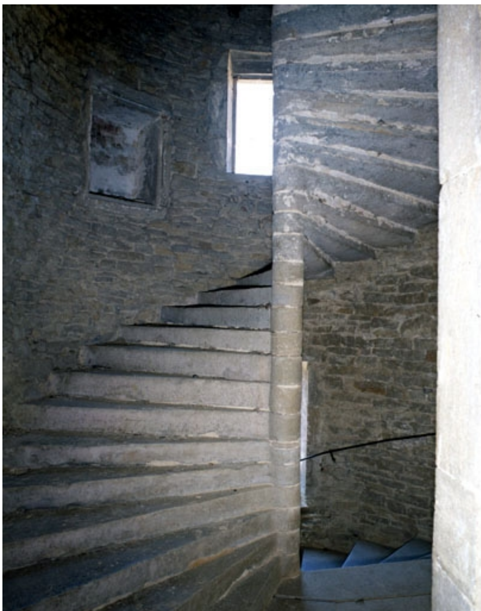
Escalier en vis de la tourelle.
